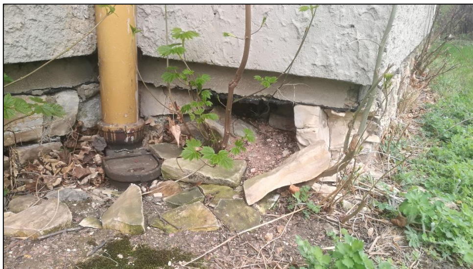
Foto č. 13 – Dtto Foto č. 12, obnažená hydroizolace.
