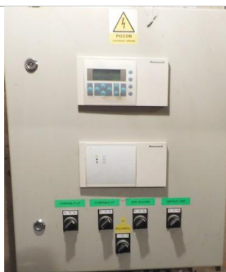
výměník a jeho regulace
