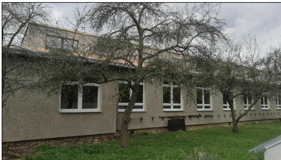
Foto č. 9 – Pavilon č. II – východní pohled, výškové odskočení opačně orientovaných pultových střech.
