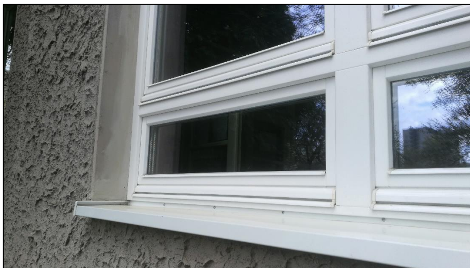
Foto č. 30 – Nová Eurookna s izolačním dvojsklem.
