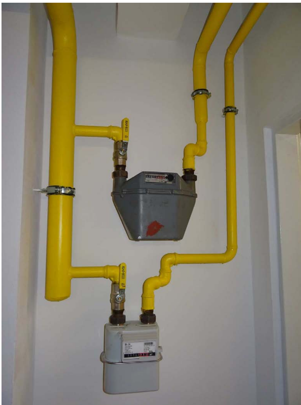
Obrázek 31 – Napojení plynoměrů – školní kuchyně, byt
