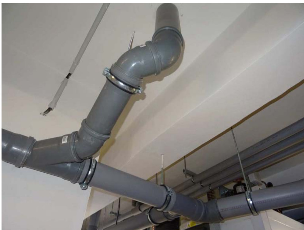
Obrázek 28 – Ležaté plastové rozvody kanalizace (PP-HT) – dobrý stav
