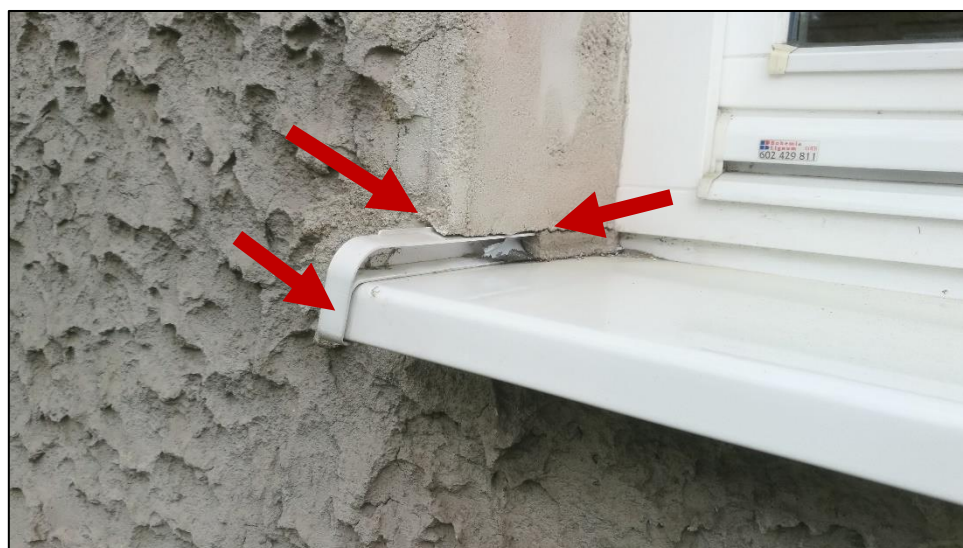
Foto č. 41 – Netěsné osazení bočních plastových krytek na oplechování – deformace. Nevhodné provedení v detailu ostění, omítka dotažena k boční krytce bez pružného napojení – trhliny, netěsnosti.
