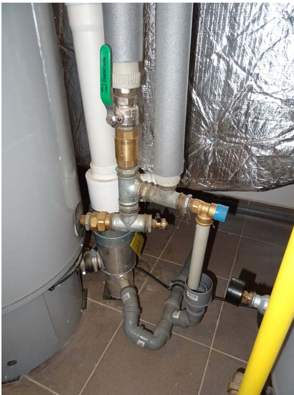
Obrázek 33 – Odvod úkapů z pojistných ventilů a kondenzačních ohřivačů do kanalizace – dobrý stav
