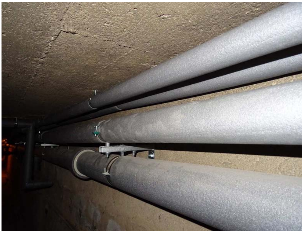
Obrázek 24 – Izolované ležaté rozvody vody v kolektoru – dobrý stav
