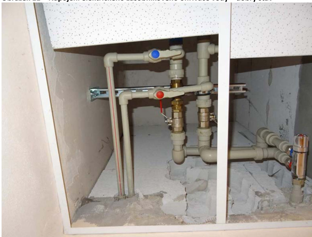
Obrázek 12 – Směšovací armatura studené a teplé vody
