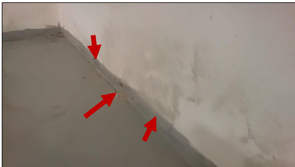
Foto č. 19 – Dtto Foto č. 18.
