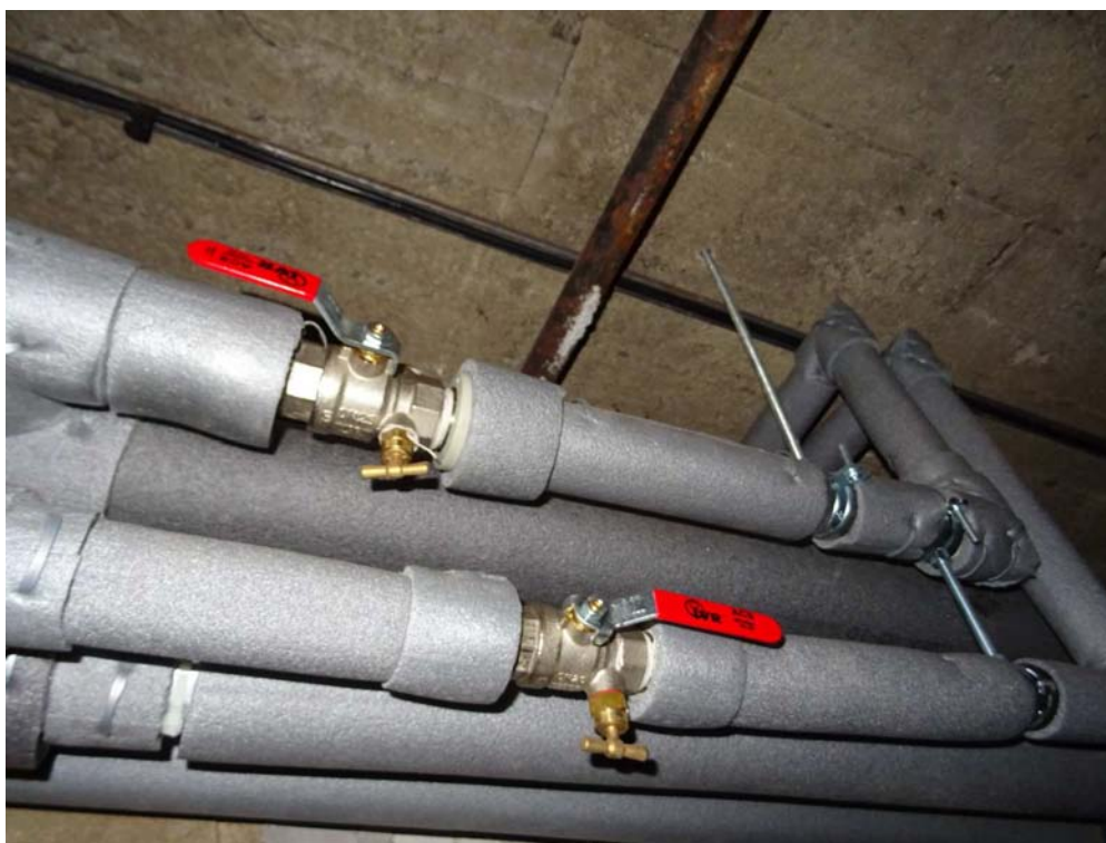
Obrázek 20 – Plastové rozvody vody, uzávěry, vč. izolací – dobrý stav
