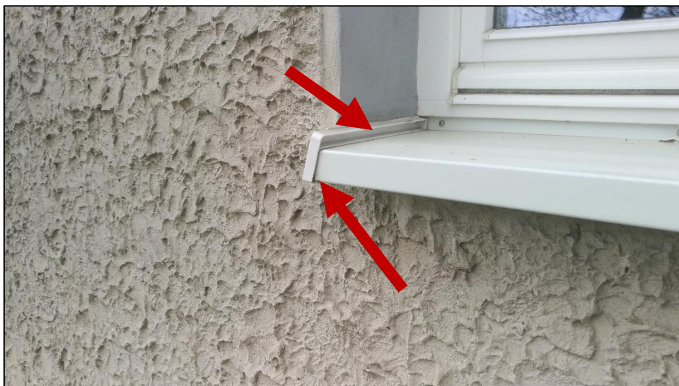
Foto č. 45 – Dtto Foto č. 41.
