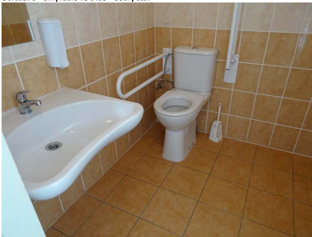
Obrázek 10 – Toaleta pro tělesně postižené – dobrý stav
