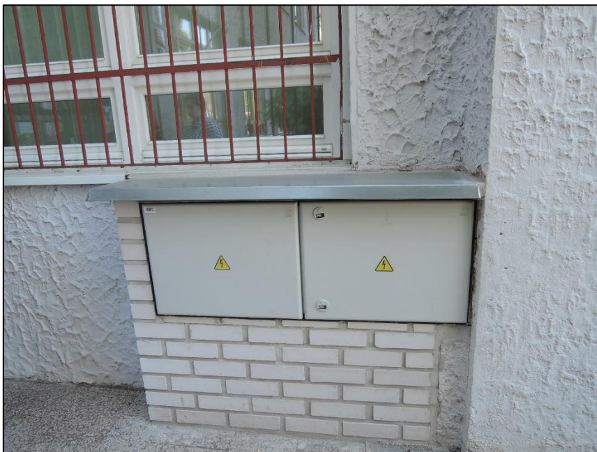
Foto č. 1 – Přípojka, pojistková skříň PRE
