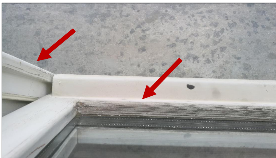
Foto č. 33 – Dtto Foto č. 32.
