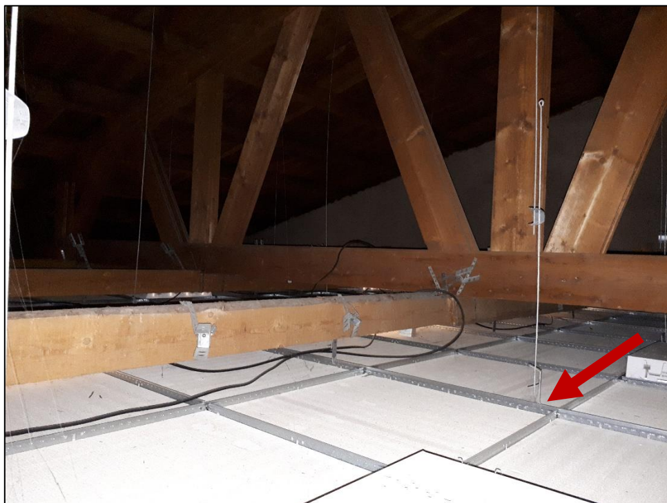
Foto č. 26 – Prostor vazníkové střechy, kazetový podhled s rozvody elektřiny ke stropním svítidlům.
