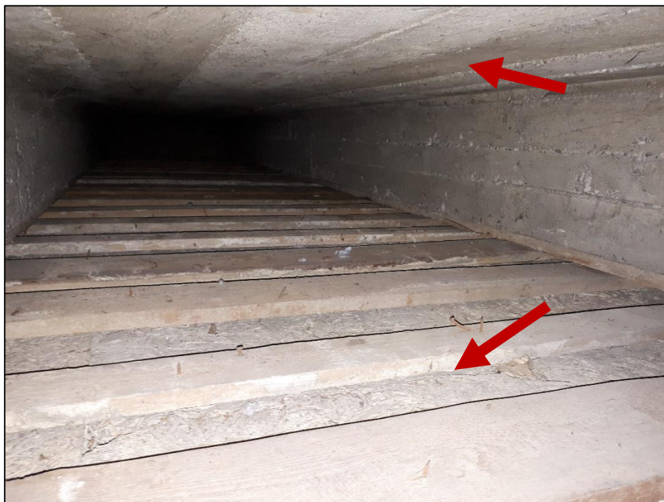
Foto č. 28 – Konstrukce stropu pod půdou hlavní budovy – monolitický ŽB strop, pohled s tepelnou izolací typu Heraklith.
