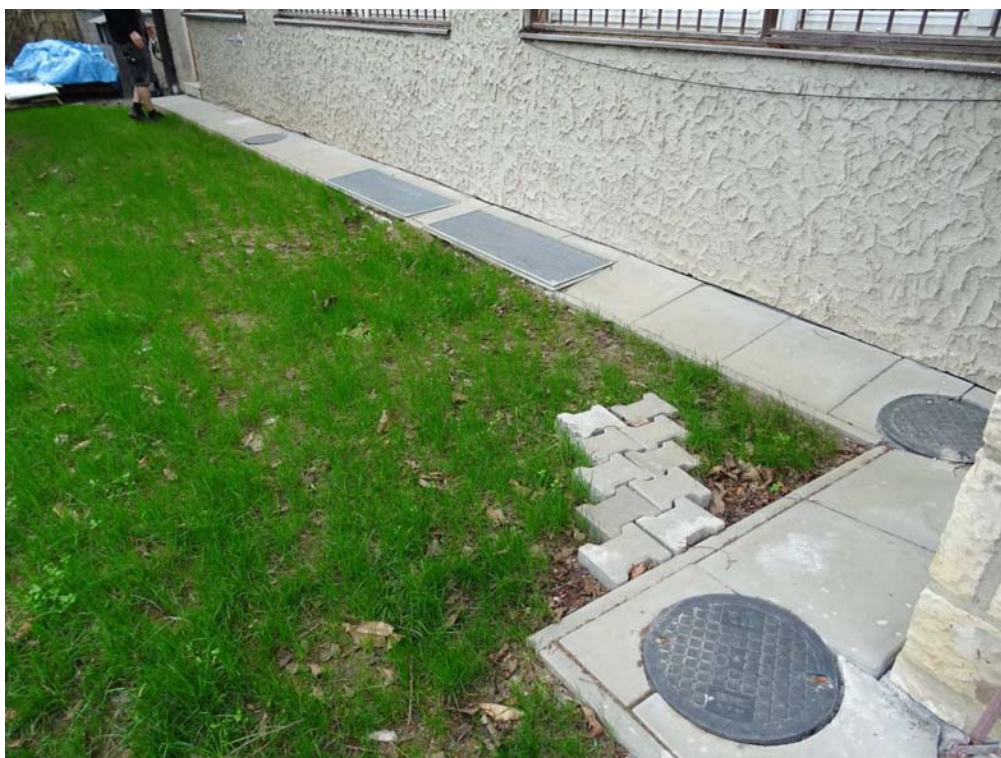
Obrázek 7 – Drenážní sedimentační šachty – dobrý stav
