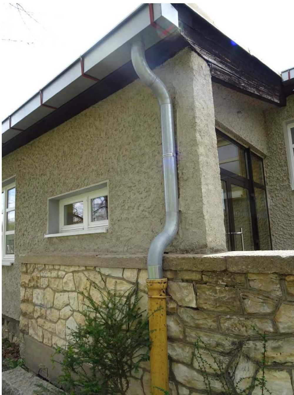
Obrázek 3 – Napojení pozinkovaného svodu do litinové trouby
