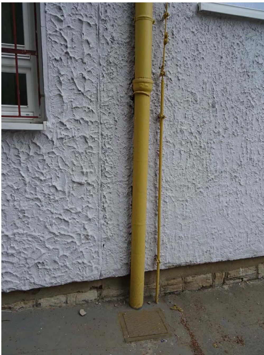
Obrázek 63 – Původní litinový svod – udržovaný stav
