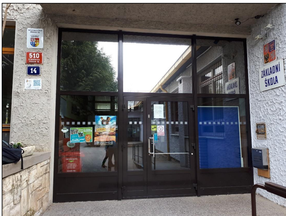
Foto č. 29 – Nový hlavní vstup – Al rám + izolační dvojsklo.
