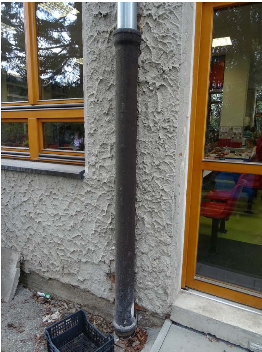
Obrázek 6 – Litinová trouba mezi lapačem a pozinkovaným svodem – udržovaný stav
