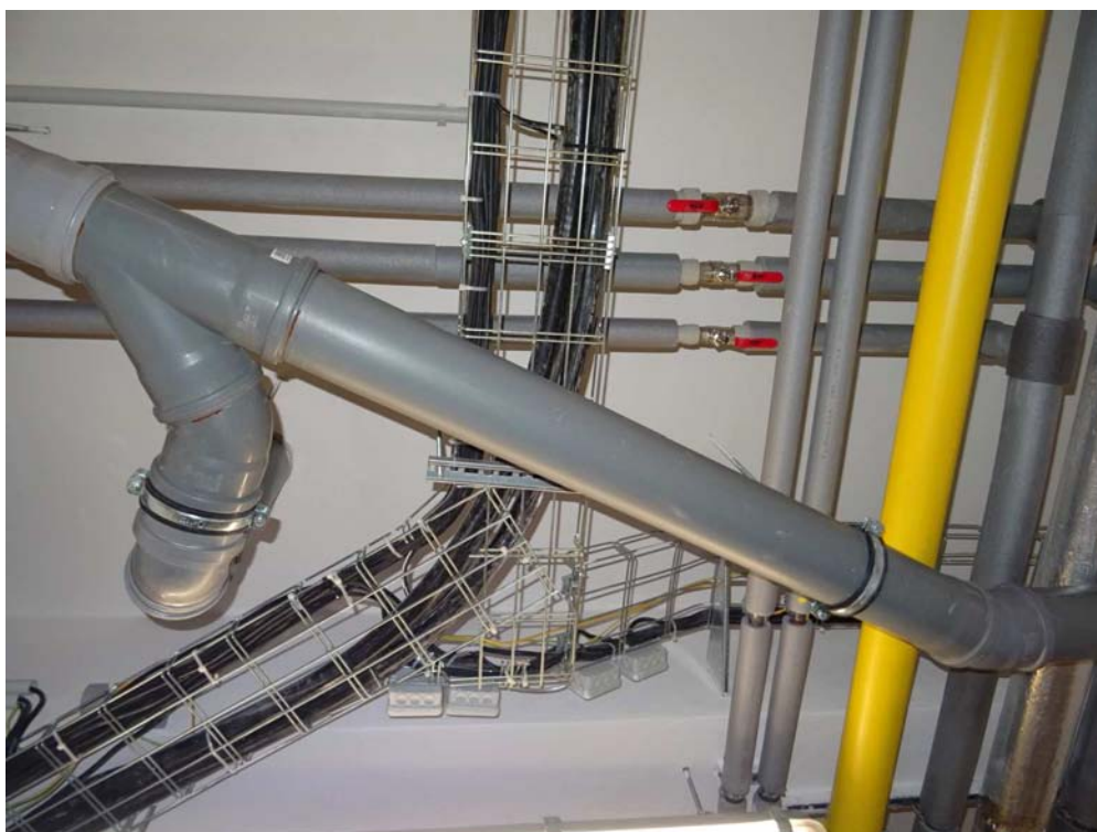
Obrázek 26 – Plastové ležaté rozvody kanalizace – dobrý stav
