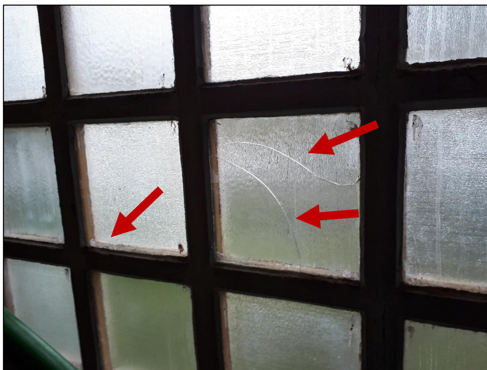
Foto č. 39 – Dtto Foto č. 38.
