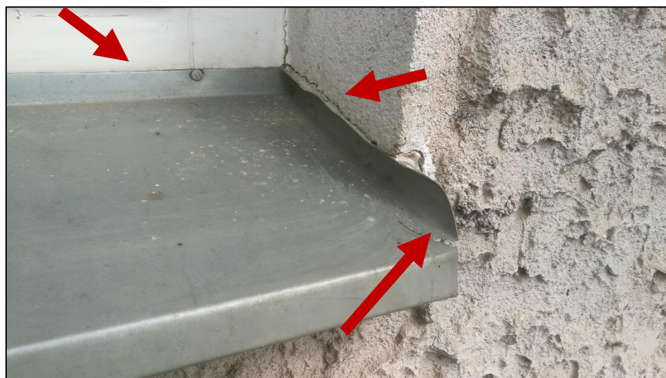
Foto č. 41 – Netěsné osazení bočních plastových krytek na oplechování – deformace. Nevhodné provedení v detailu ostění, omítka dotažena k boční krytce bez pružného napojení – trhliny, netěsnosti.
