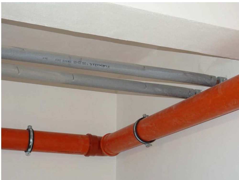
Obrázek 37 – Rozvod kanalizace z PVC-KG a rozvod vody – dobrý stav
