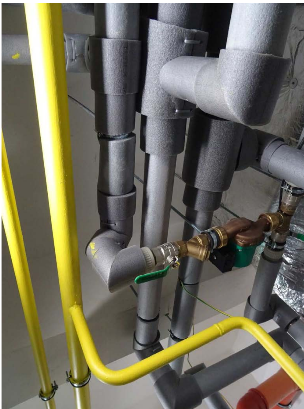
Obrázek 32 – Napojení plynových zásobníkových ohřivačů TV – dobrý stav
