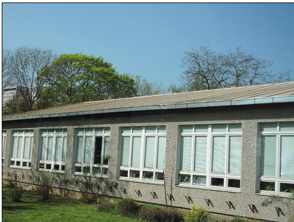
Foto č. 22 – Hromosvod – svod
