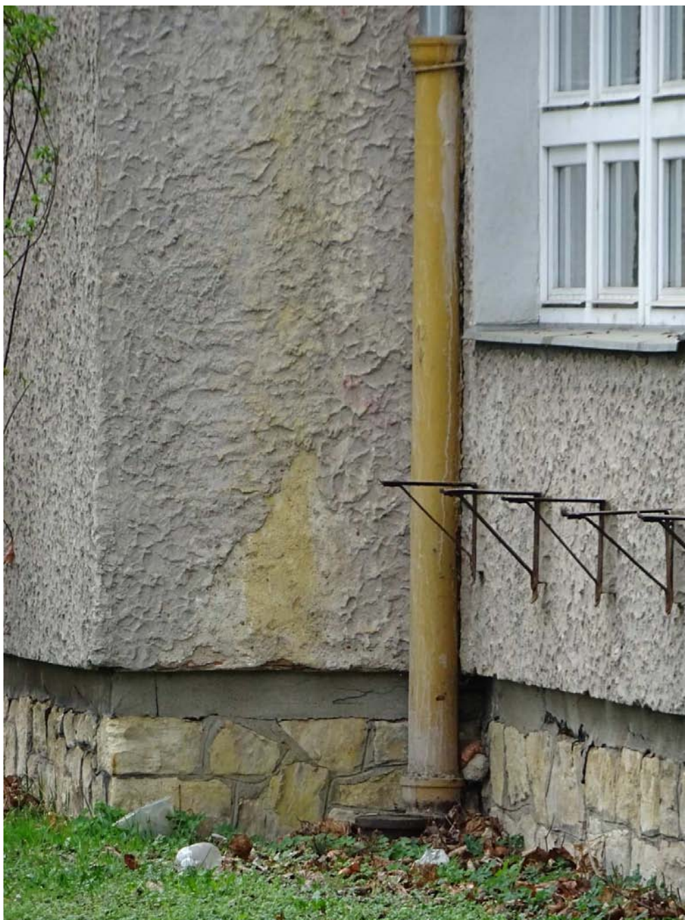
Obrázek 1 – Litinový dešťový svod napojen do lapače splavenin – špatný stav
