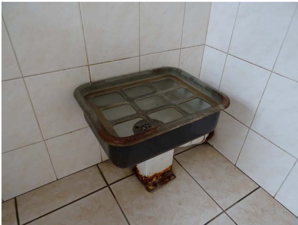
Obrázek 60 – Původní výlevka – opotřebovaný stav
