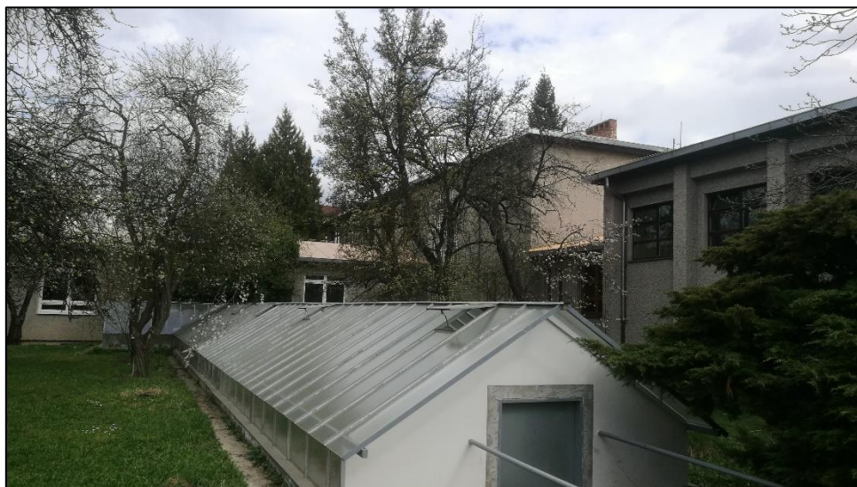
Foto č. 3 – Jihozápadní pohled na hlavní budovu, tělocvičnu. V popředí skleník v atriu mezi pavilony.
