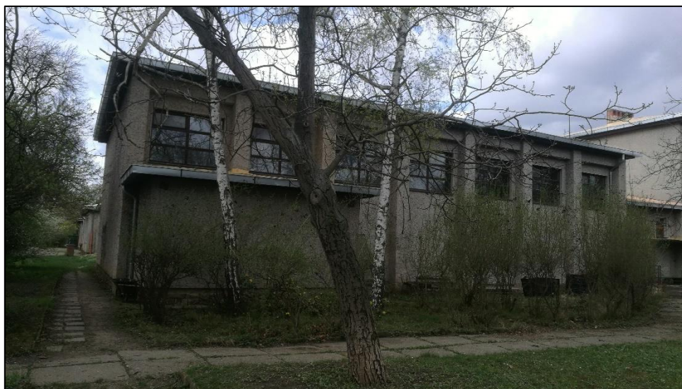
Foto č. 5 – Tělocvična – východní pohled.
