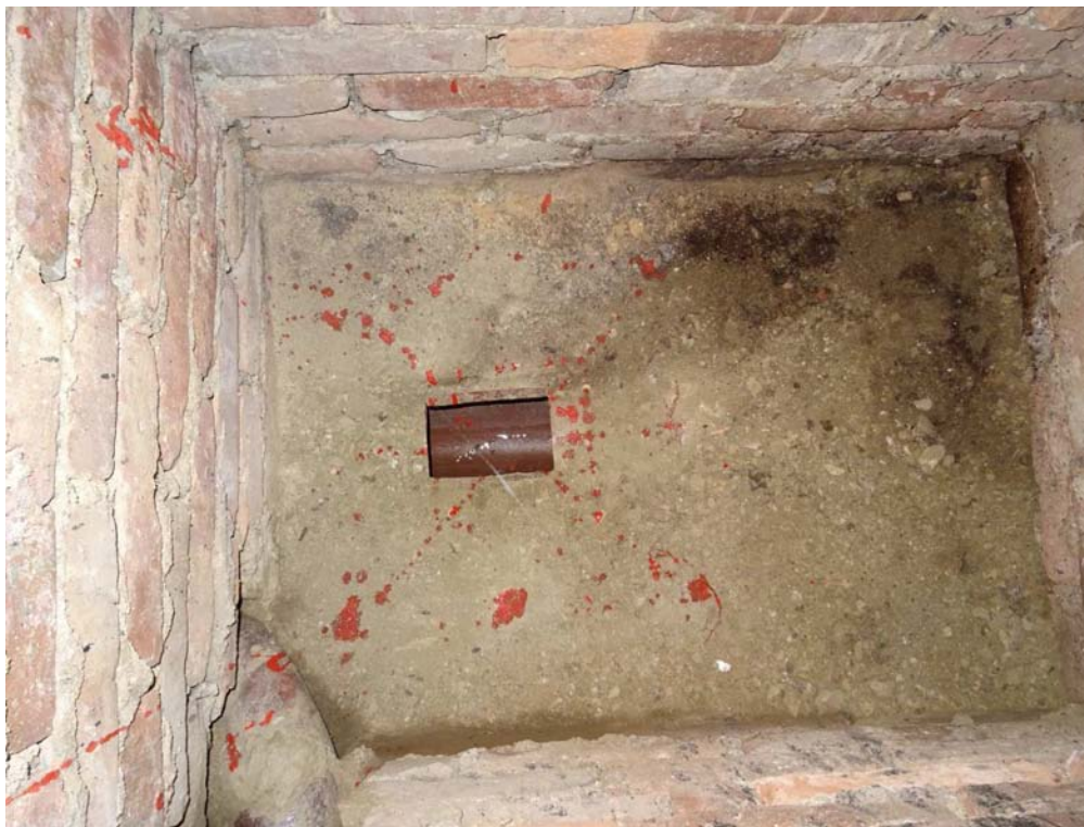
Obrázek 47 – Revizní kus kameninového ležatého potrubí v revizní šachtě – dobrý stav
