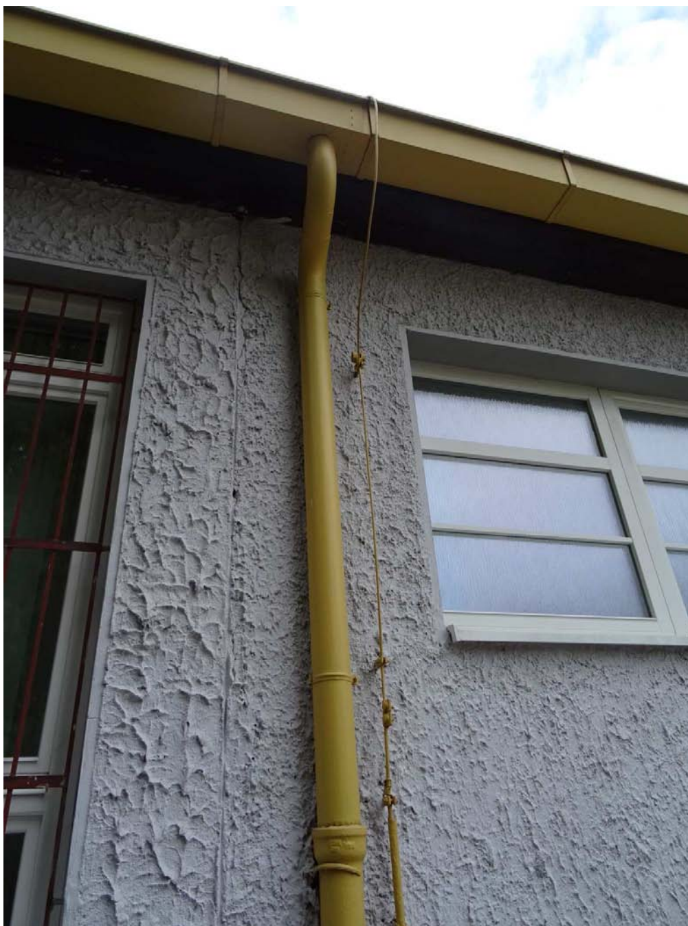
Obrázek 64 – Původní litinový svod a pozinkovaný svod – udržovaný stav
