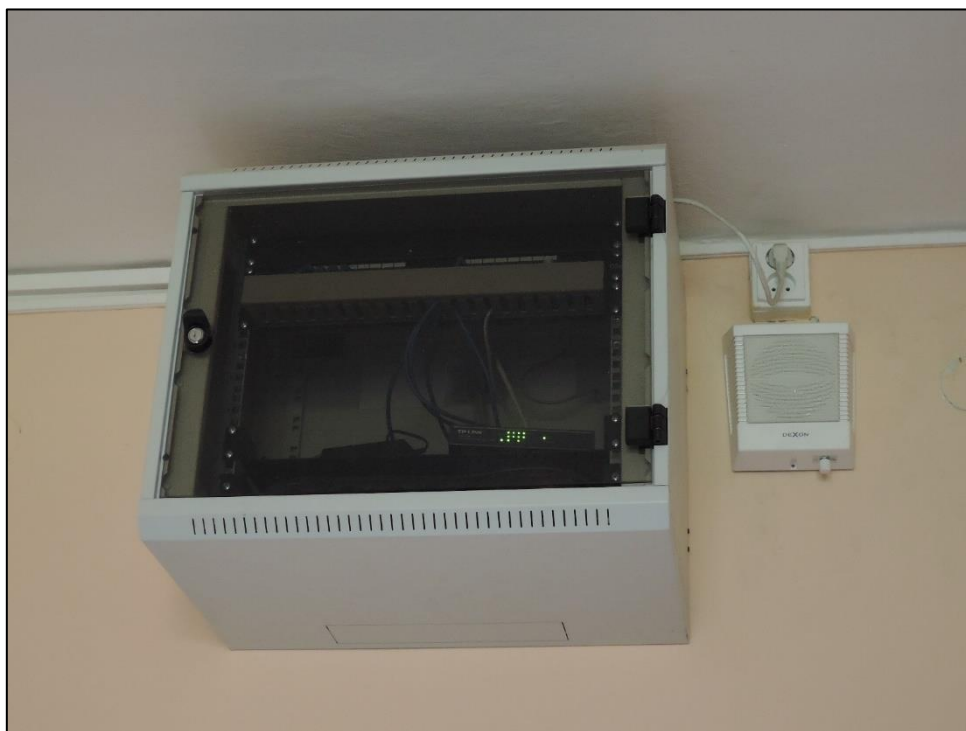
Foto č. 25 – Datový rozvaděč a reproduktor rozhlasu
