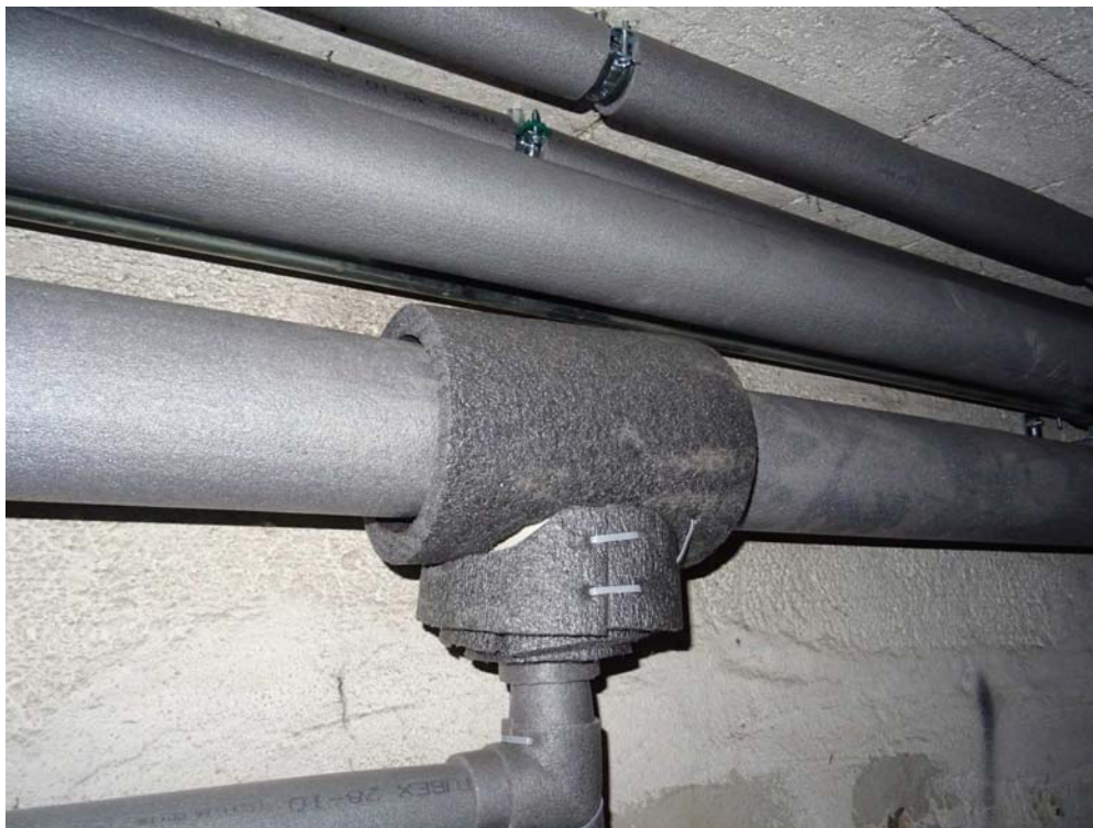
Obrázek 45 – Izolované rozvody vody – dobrý stav
