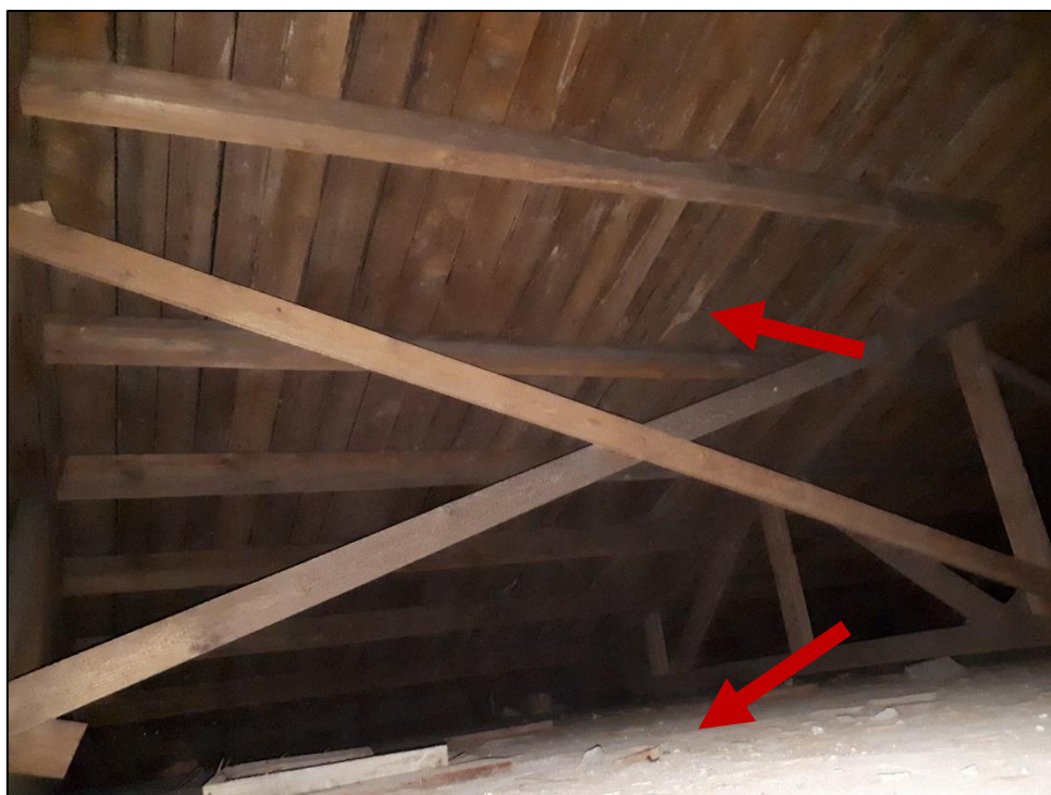
Foto č. 27 – Půdní prostor hlavní budovy.
