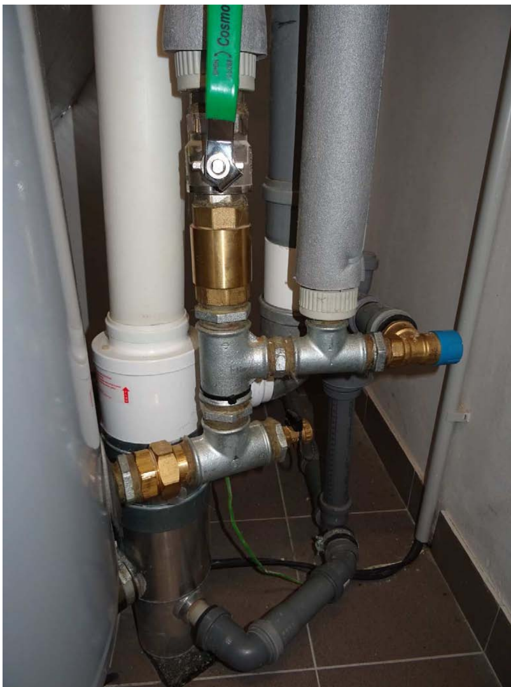
Obrázek 34 – Napojení rozvodů vody na plynový ohřívač TV
