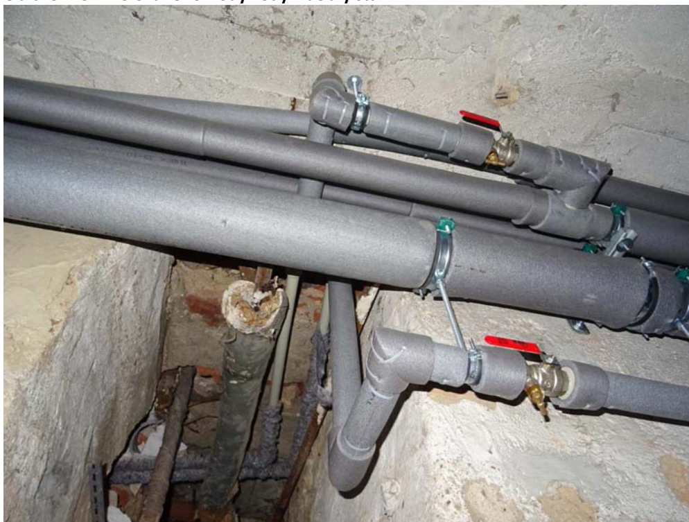
Obrázek 46 – Izolované rozvody vody – dobrý stav
