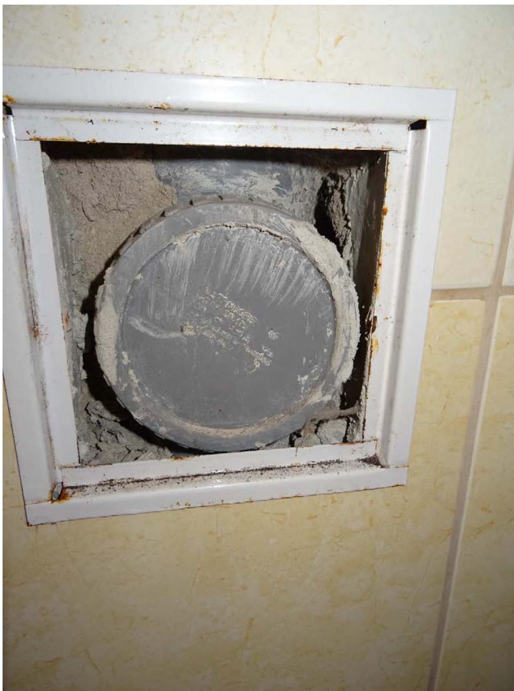
Obrázek 39 – Čistící kus plastového svodu kanalizace – dobrý stav
