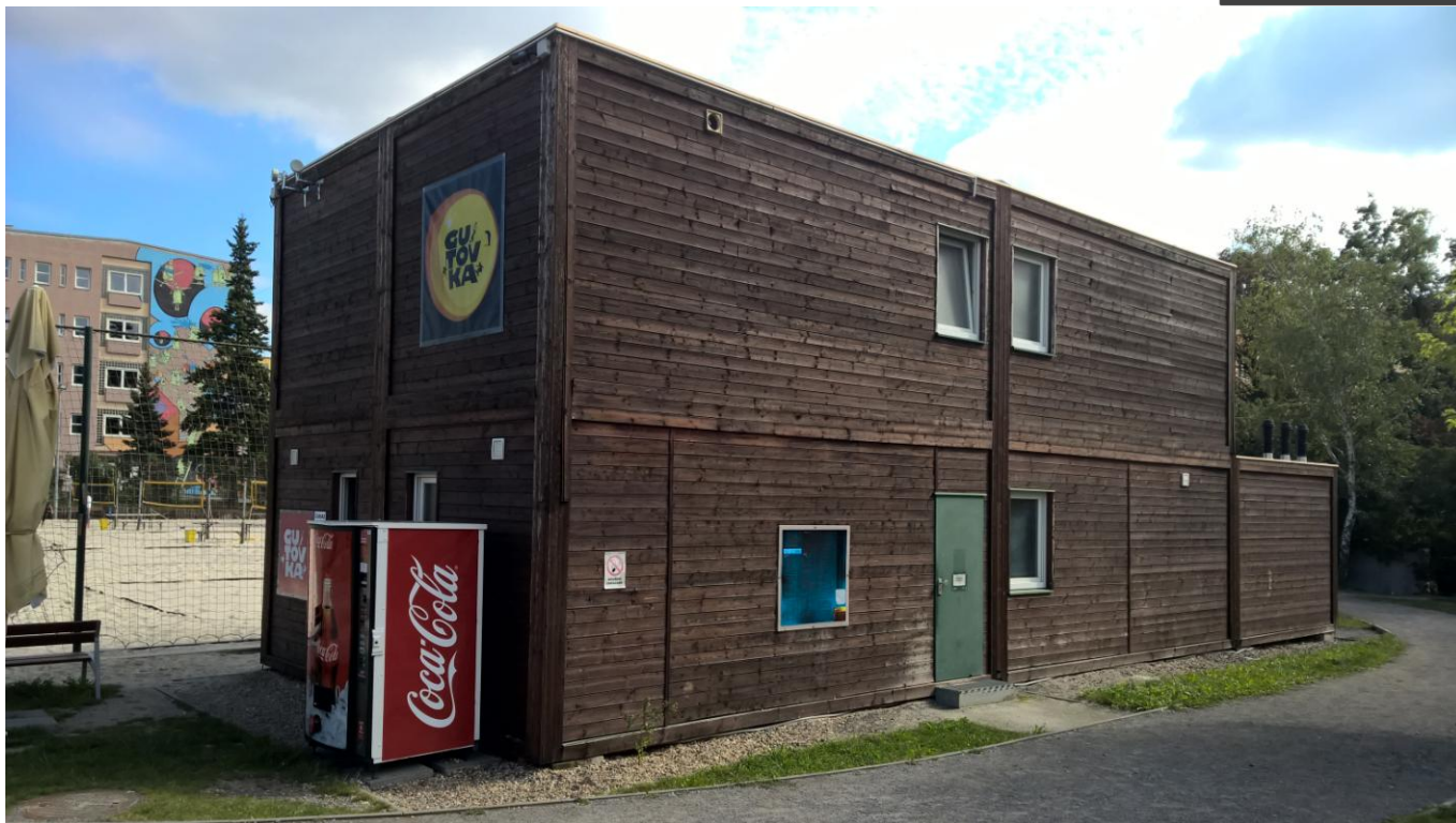
Obrázek 7 - objekt zázemí s šatnami
