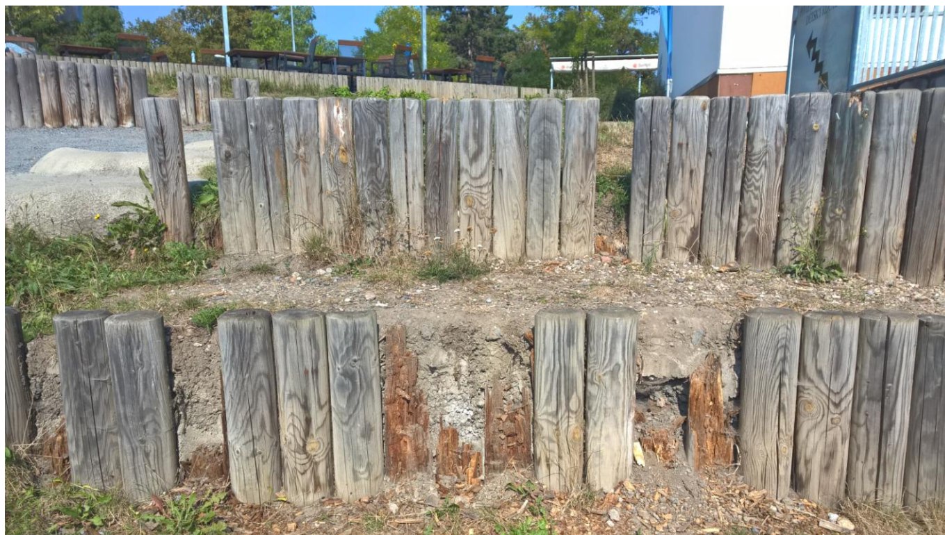
Obrázek 3- v Gutovce je přibližně 2.000 ks palisád, z nichž přibližně 500 potřebuje obměnu. Na vině je nevhodné uložení.
