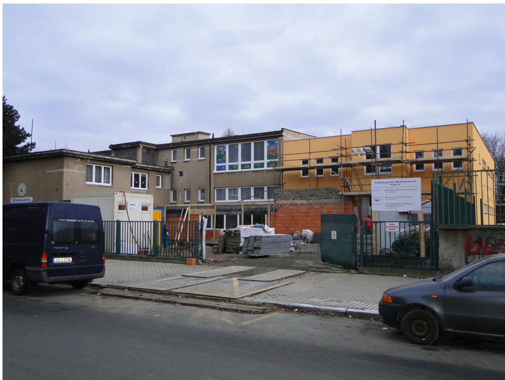
Přístavba pavilonu MŠ Vladivostocká
