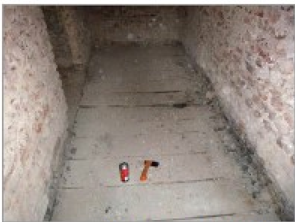
foto 21, 22: Hrubou téměř zničená stropní konstrukce nad 3.NP v nárožní části budovy
