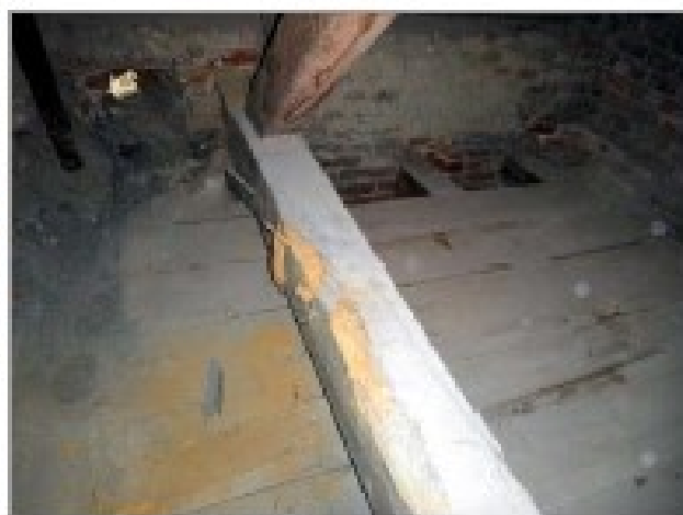
foto 16: Vazný trám krovu vážně poškozený dřevokazným hmyzem
