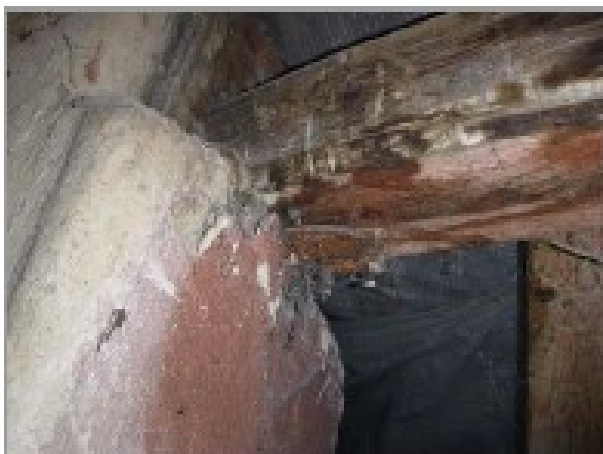
foto 7: Detail uložení hřebenevé vaznice na štitovou zeď
