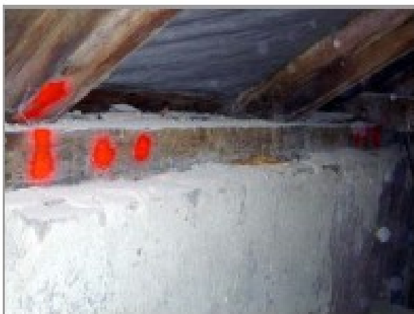
foto 11, 12: Pozednice krovu poškozená dřevní hnilobou a dřevokazným hmyzem
