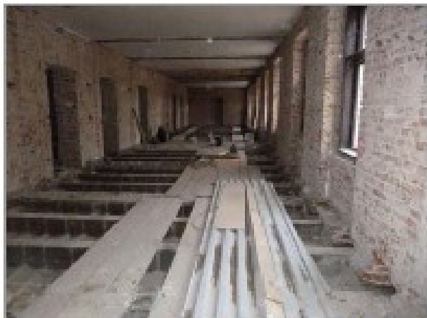
foto 31, 32: Odhalené stropní konstrukce nad 1.NP v severním resp. jižním křídle budovy
