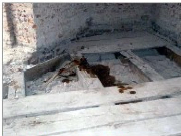
foto 21, 22: Hrubou téměř zničená stropní konstrukce nad 3.NP v nárožní části budovy
