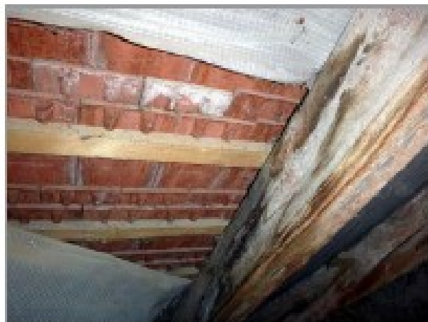
foto 8: Detail keramické střešní krytiny na dřevěném latování
