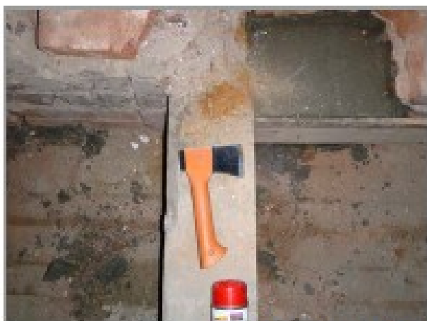
foto 35, 36: Detail vážně poškozených trámových zhlaví stropu nad 1.NP
