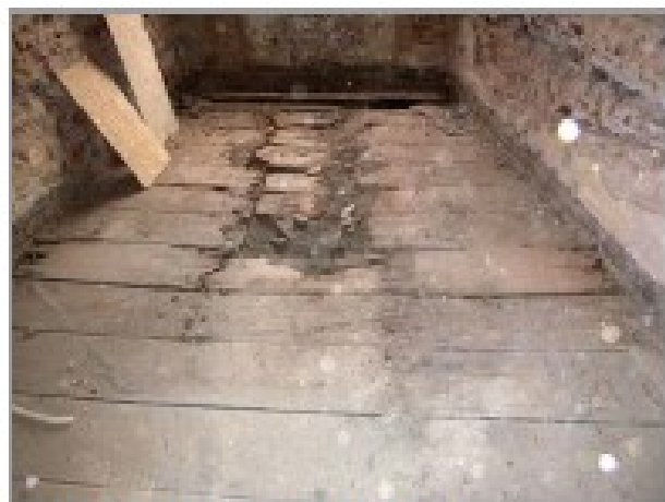
foto 29, 30: Odhalené a dřevní hnilobou téměř zničené stropy nad 2.NP v jižním křídle budovy
