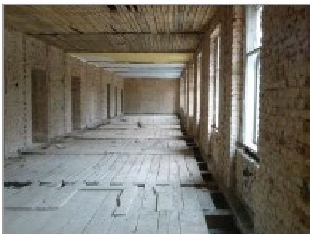
foto 25, 26: Odhalené stropní konstrukce nad 2.NP v severním křídle budovy
