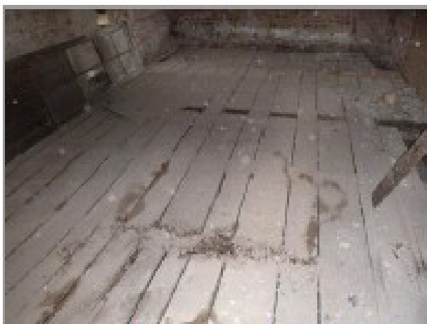
foto 29, 30: Odhalené a dřevní hnilobou téměř zničené stropy nad 2.NP v jižním křídle budovy
