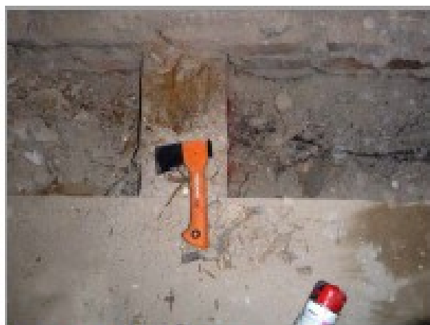
foto 35, 36: Detail vážně poškozených trámových zhlaví stropu nad 1.NP
