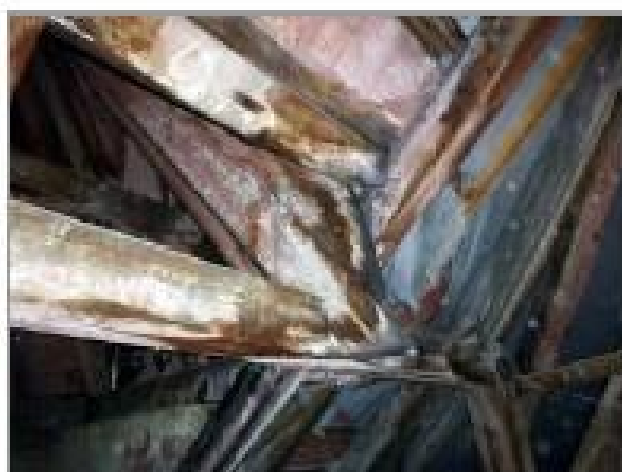
foto 5, 6: Konstruktivní prvky staré konstrukce dřevěného krovu se zbytky protipožárního nátěru a "mapami" od zatékání
