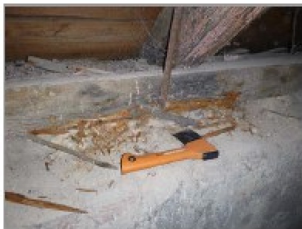
foto 11, 12: Pozednice krovu poškozená dřevní hnilobou a dřevokazným hmyzem
