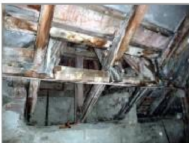
foto 5, 6: Konstruktivní prvky staré konstrukce dřevěného krovu se zbytky protipožárního nátěru a "mapami" od zatékání
