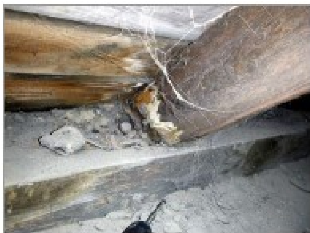
foto 13, 14: Detail styků krokve a pozednice poškozených dřevní hnilobou
