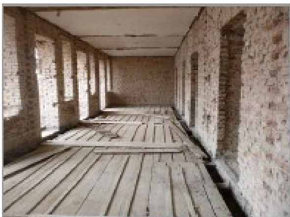
foto 18, 20: Odhalená stropní konstrukce nad 3.NP v severním resp. jižním křídle budovy
