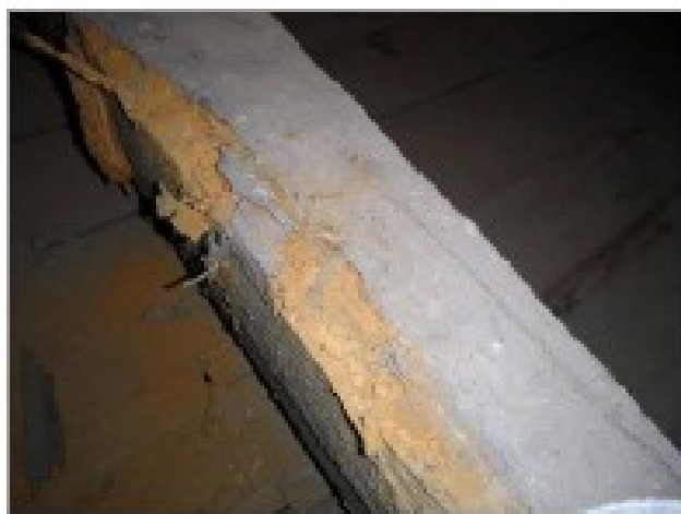
foto 17, 18: Detail vazného trámu krovu s vážným poškozením dřevokazným hmyzem
