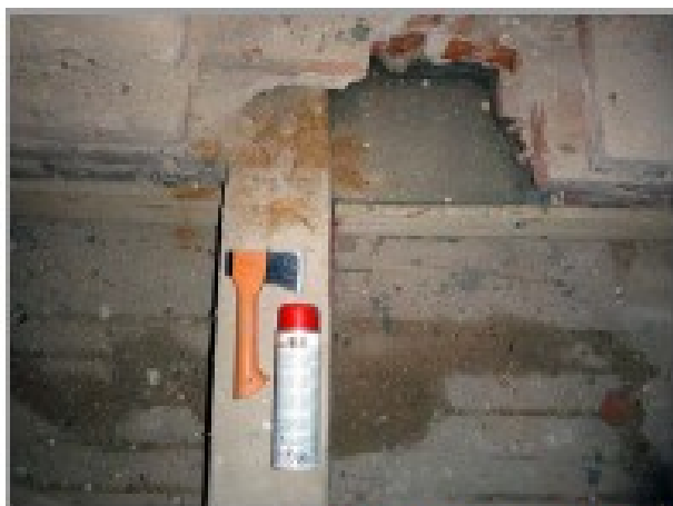
foto 33, 34: Detail vážně poškozených trámových zhlaví stropu nad 1.NP
