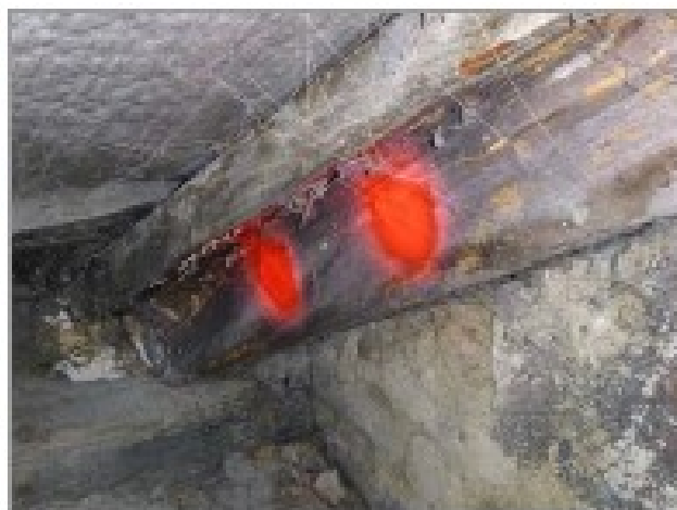
foto 13, 14: Detail styků krokve a pozednice poškozených dřevní hnilobou
