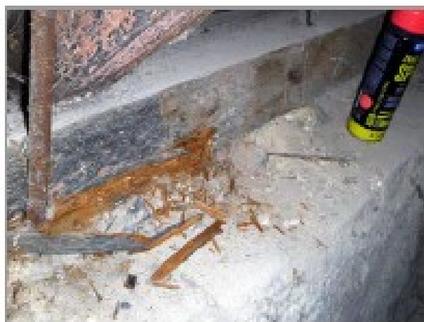
foto 9, 10: Pozednice krovu poškozená dřevní hnilobou a dřevokazným hmyzem
