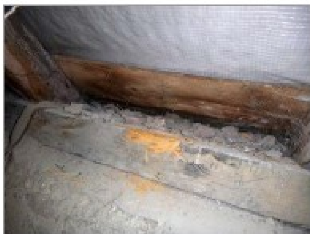
foto 15: Pozednice krovu poškozená dřevokazným hmyzem
