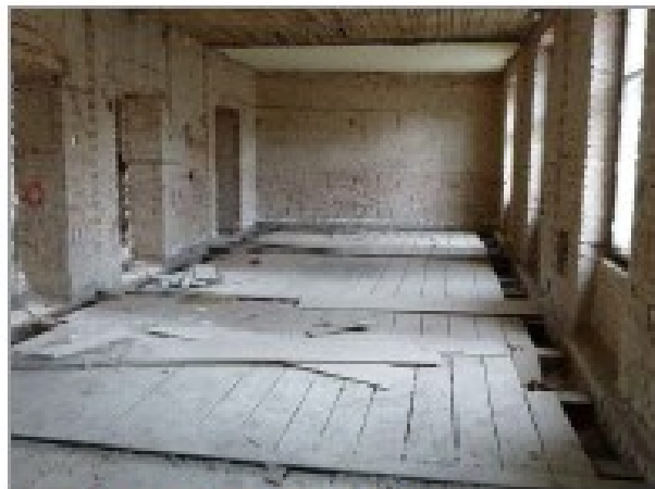
foto 31, 32: Odhalené stropní konstrukce nad 1.NP v severním resp. jižním křídle budovy
