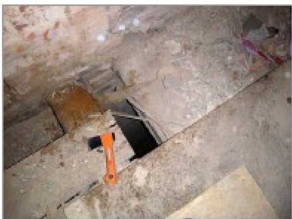
foto 23, 24: Detail vážně poškozených trámových žlávků stropu nad 3.NP
