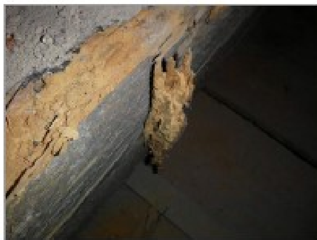
foto 17, 18: Detail vazného trámu krovu s vážným poškozením dřevokazným hmyzem
