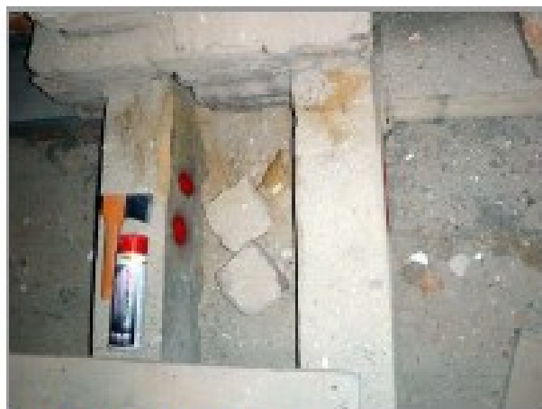
foto 33, 34: Detail vážně poškozených trámových zhlaví stropu nad 1.NP
