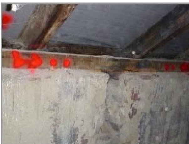
foto 9, 10: Pozednice krovu poškozená dřevní hnilobou a dřevokazným hmyzem
