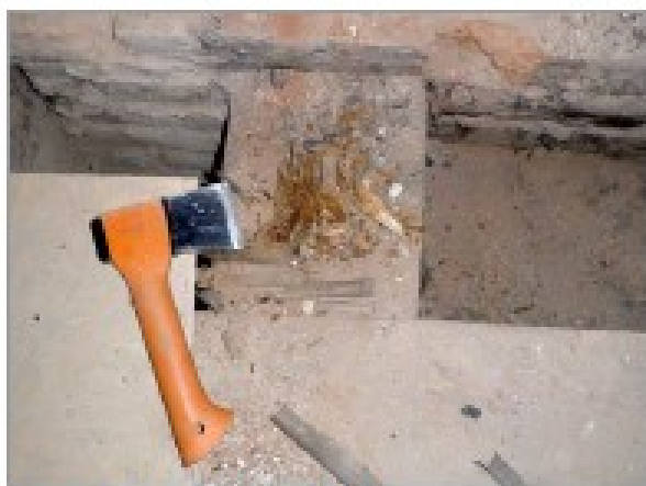
foto 23, 24: Detail vážně poškozených trámových žlávků stropu nad 3.NP
