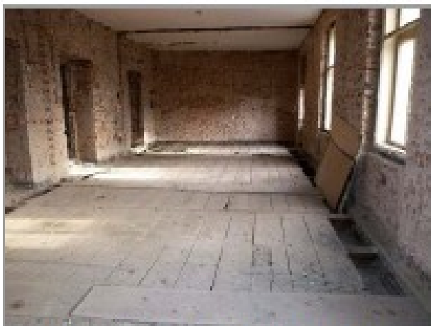
foto 27: Odhalený strop nad 2.NP v jižním křídle budovy
