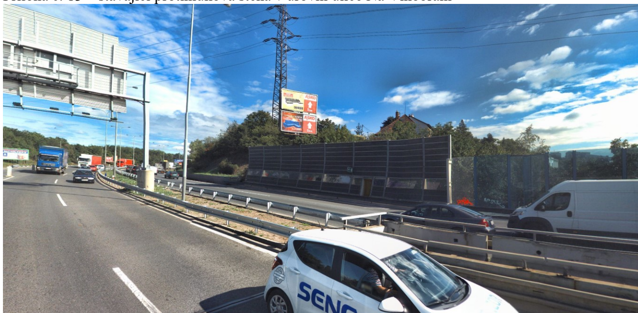
Příloha č. 13 – stávající protihluková stěna v úrovni ulice Na Vinobraní
