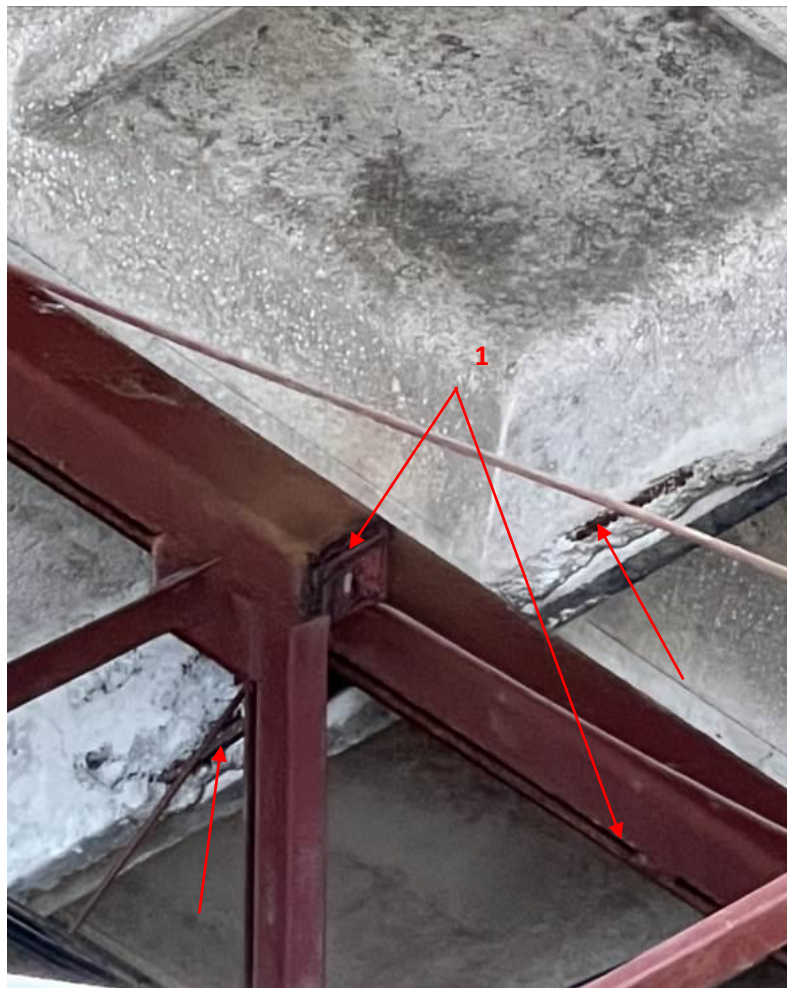
Obr. 4 Detailní pohled na stávající střešní konstrukci v místě poškozených žeber v místě uložení na vazník
