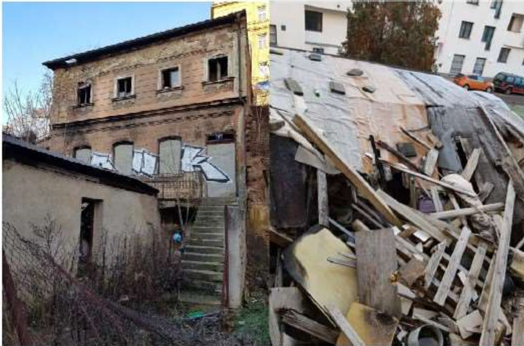
Čelní pohled na fasádu, s garáží nalevo 01/2020
