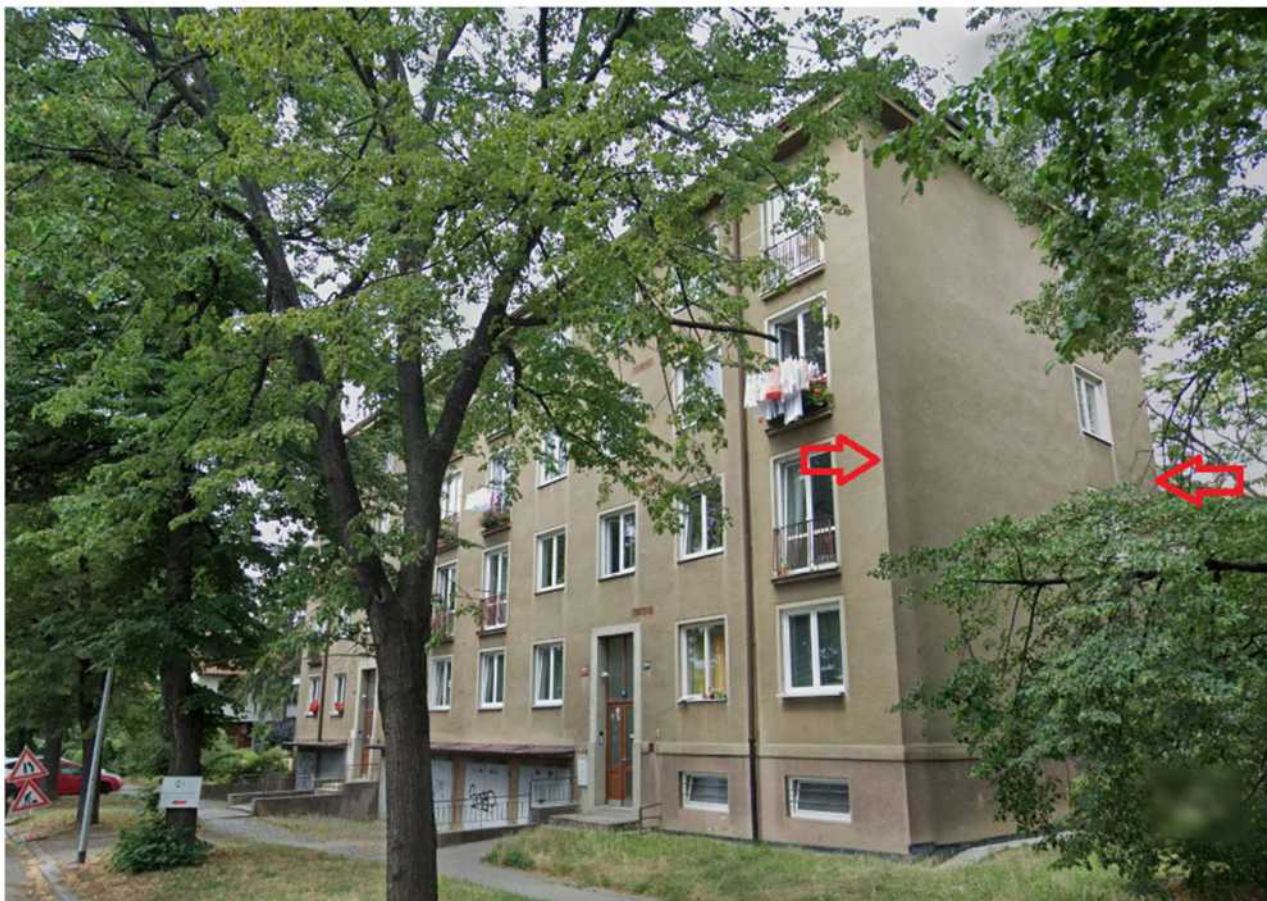
Pohled na nároží a východní štít domu č. p. 1934 s budoucím přesahem zateplení nad pozemek parc. č. 2773/1, k. ú. Strašnice (ve správě MČ Praha 10) z ulice Dvouletky
