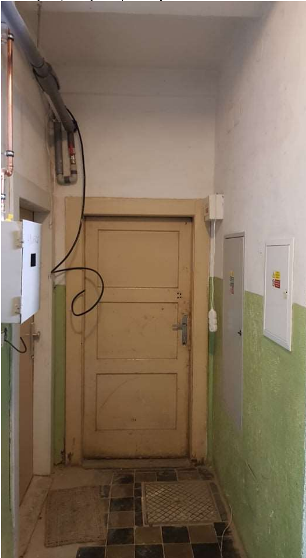
Prostor bývalé prádelny – vstup z chodby
