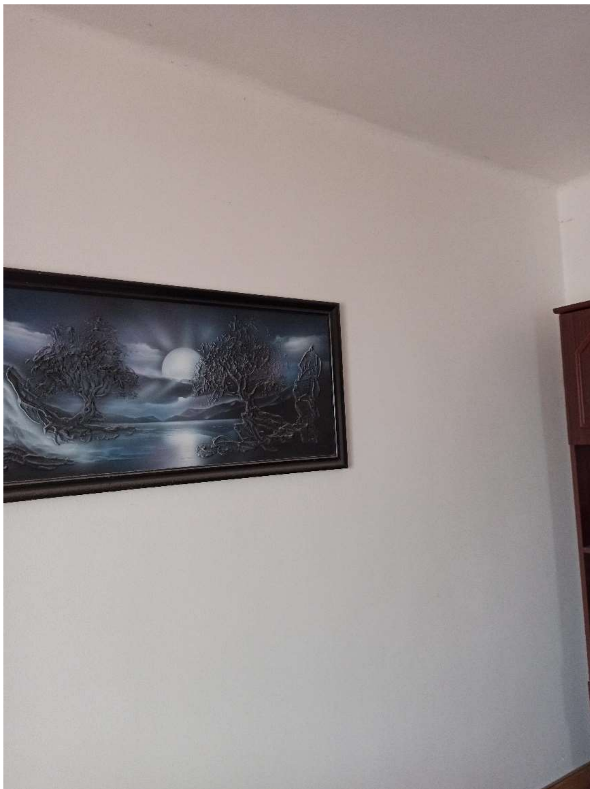
Příloha č. 4 - Fotodokumentace současného stavu stěn a stropu v bytě v Bytovém domě v místě, kde z druhé strany dojde k napojení Novostavby
