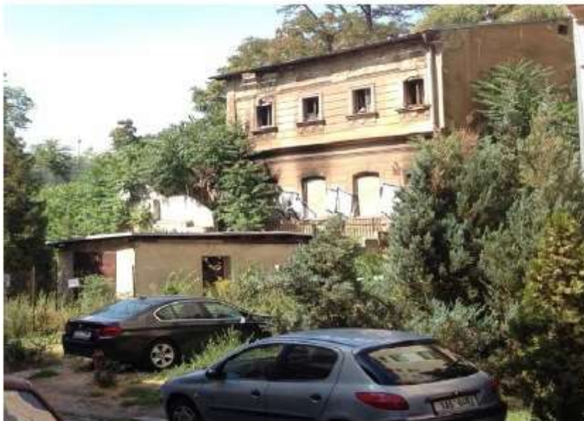
Pohled z ul. Košická, z východní části pozemku, fot. 08/2018
