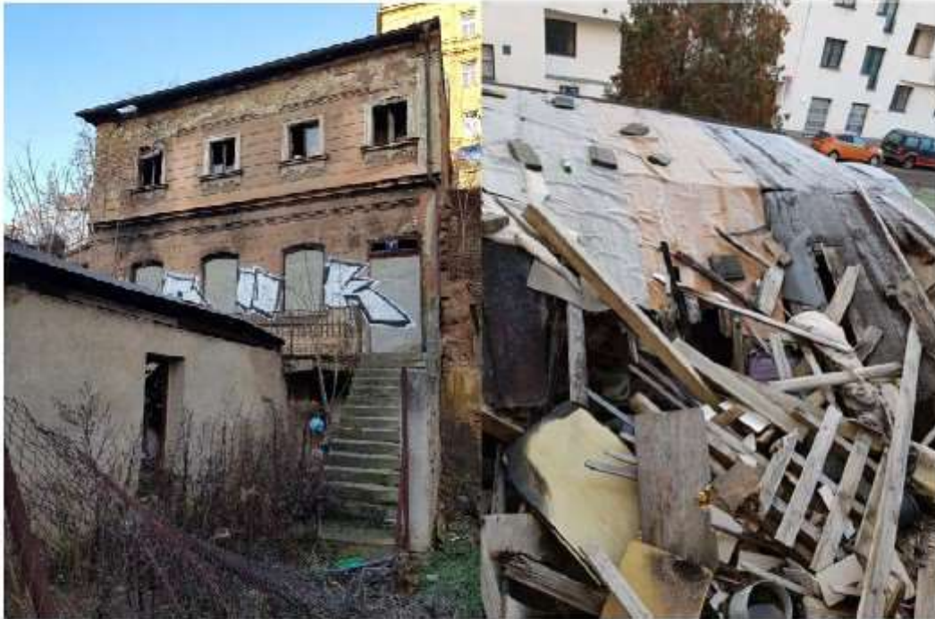
Čelní pohled na fasádu, s garáží nalevo 01/2020
