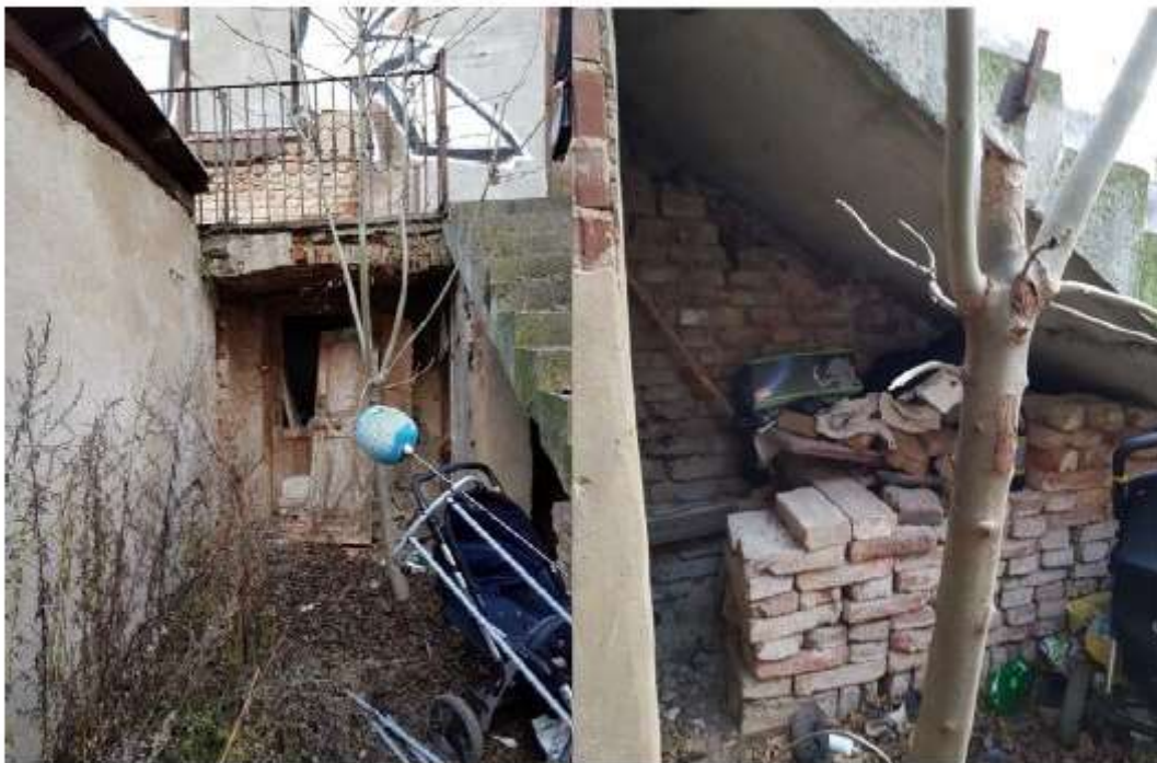
Vstup do přízemí a prostor pod schody na pavlač 01/2020
