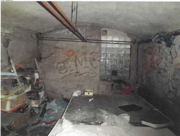
SKLADY POD BYTEM ŠKOLNÍKA (BUDOUCÍ ŠÁTNY)
