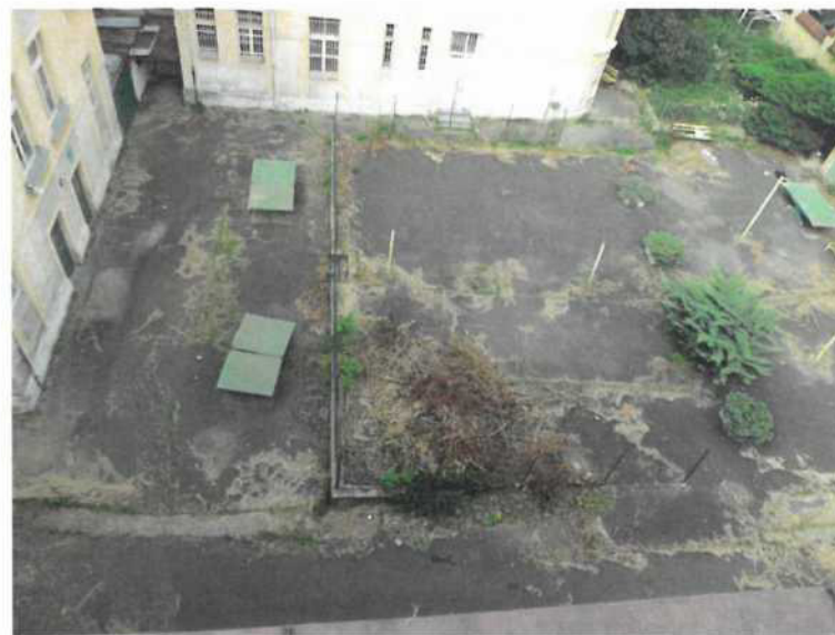
POHLED ZE STŘECHY DO DVORA
