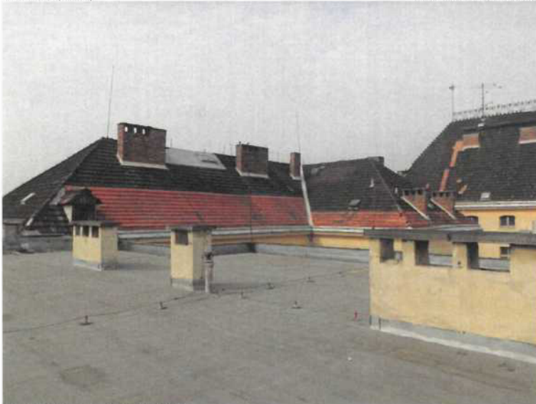
STAV STŘECH (FOCENO Z VÝCHODNÍHO KŘÍDLA)
