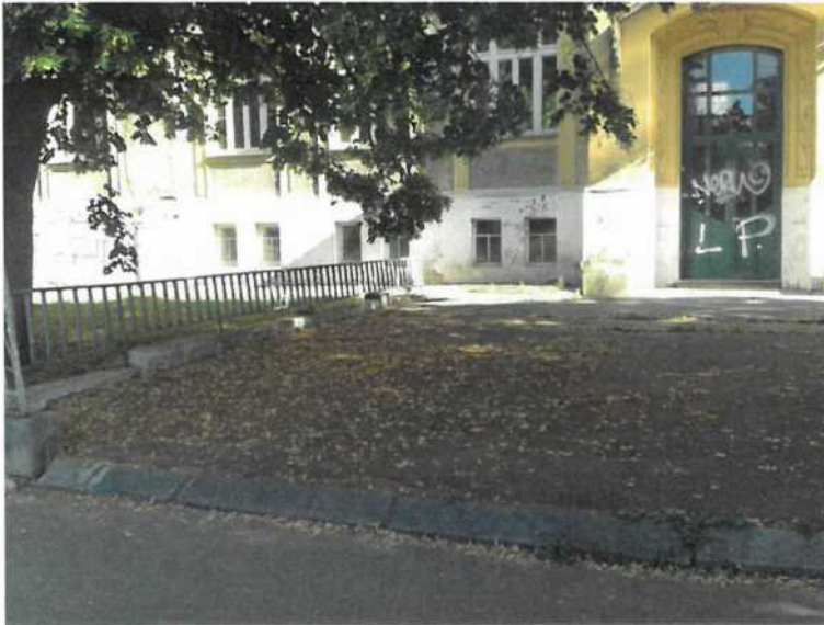
PŮVODNÍ HLAVNÍ VSTUP (Z JIHU)
