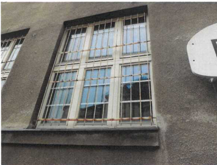
VYMĚNĚNÁ OKNA – DŘEVĚNÁ EUROOKNA S PLASTOVÝMI PŘÍČKAMI
