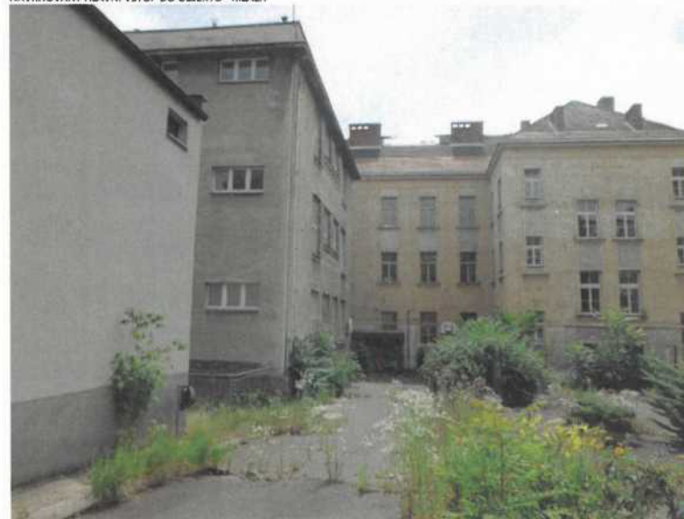
PŘÍSTAVBA VÝCHODNÍHO KŘÍDLA A TRAFOSTANICE
