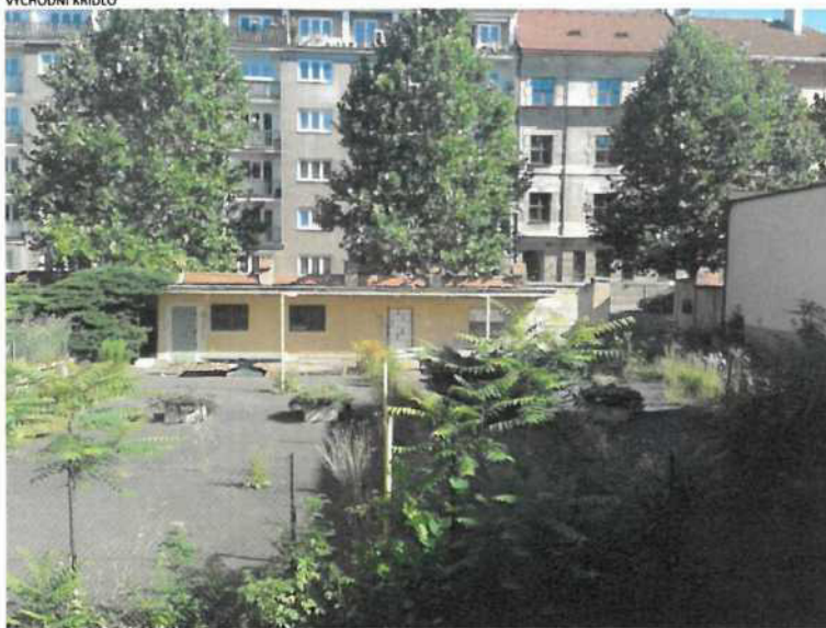
POHLED Z BUDOVOY DO DVORA NA SKLADY (RUŠÍ SE)
