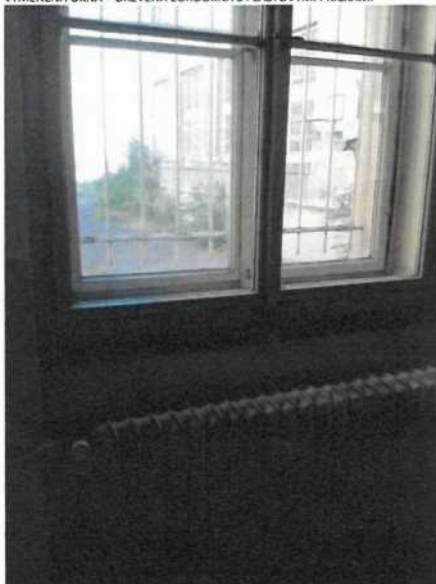
PŮVODNÍ OKNA, KAMENNÉ PARAPETY, MŘÍŽE VE VSTUPNÍM PODLAŽÍ
