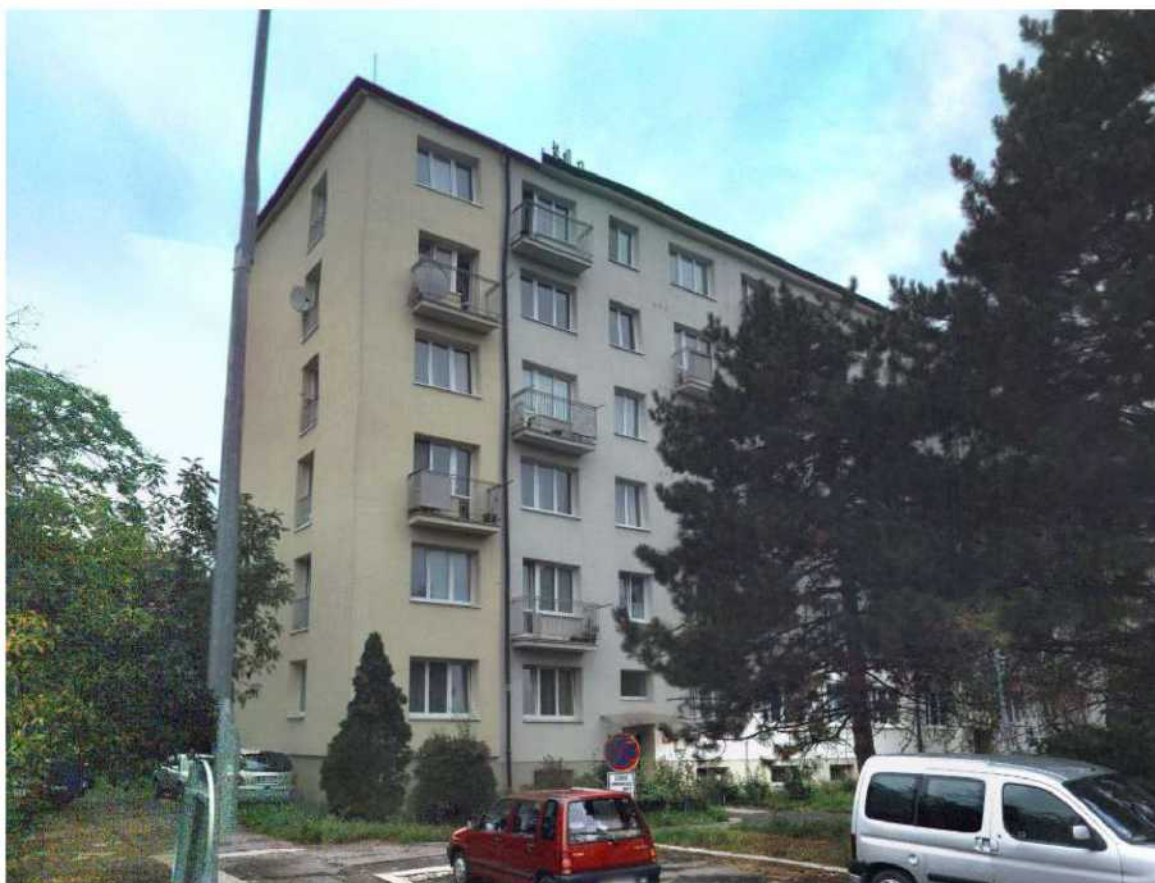
Pohled na budovy č. p. 1989 a 1990 od ulice Raffaelovy, Praha 10 - Strašnice
