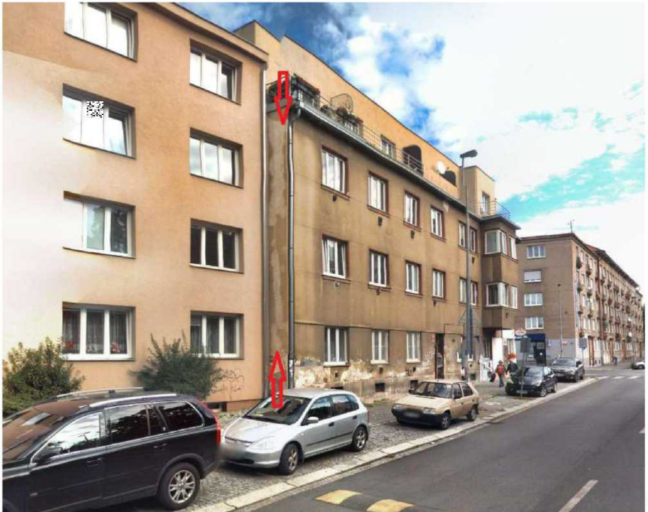
Pohled na dům č. p. 1034 a zeď s přesahem zateplení nad pozemky parc. č. 777/11 a 777/29, vše v k. ú. Strašnice (ve správě MČ Praha 10) z ulice Na Hroudě.
