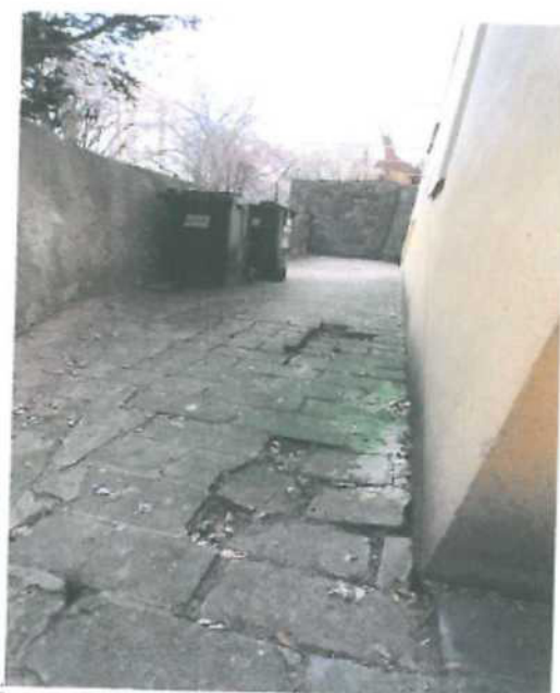
bytový dům č.p. 829, k. Louži č.10, Praha 10, k.ú. Vršovice
