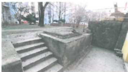
Pohled na venkovní schodiště a dvorní dlažbu
