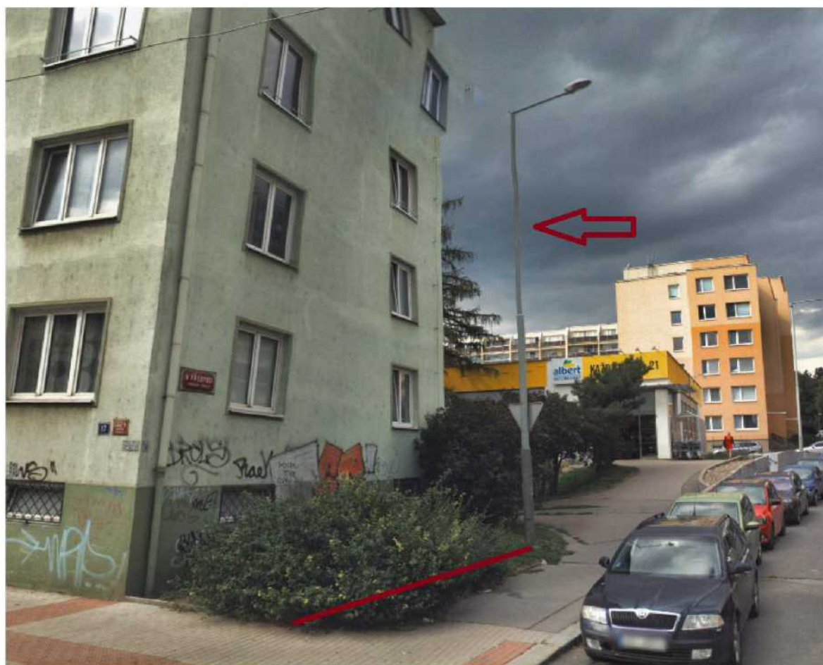
Stávající zachovaný stožár veřejného osvětlení s naznačenou trasou výkopu – pohled z ulice V Olšínách
