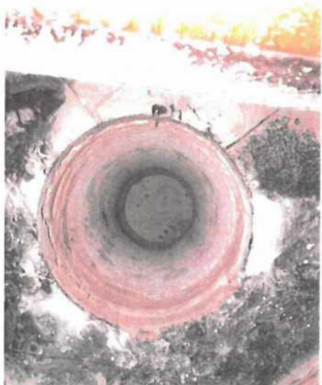
Detail zvětšeného průměru prostupu stropní konstrukcí
