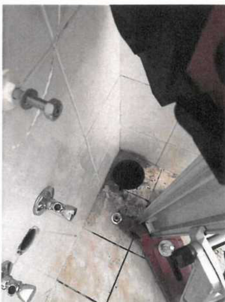
Detail zvětšeného průměru prostupu stropní konstrukcí
