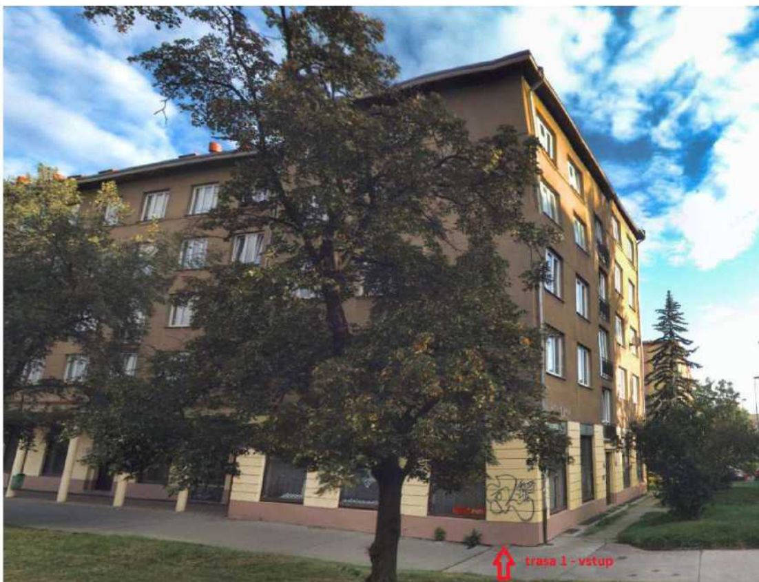
Pohled na budovy č. p. 1803 a 1804 od ulice Průběžné, Praha 10 – Strašnice
