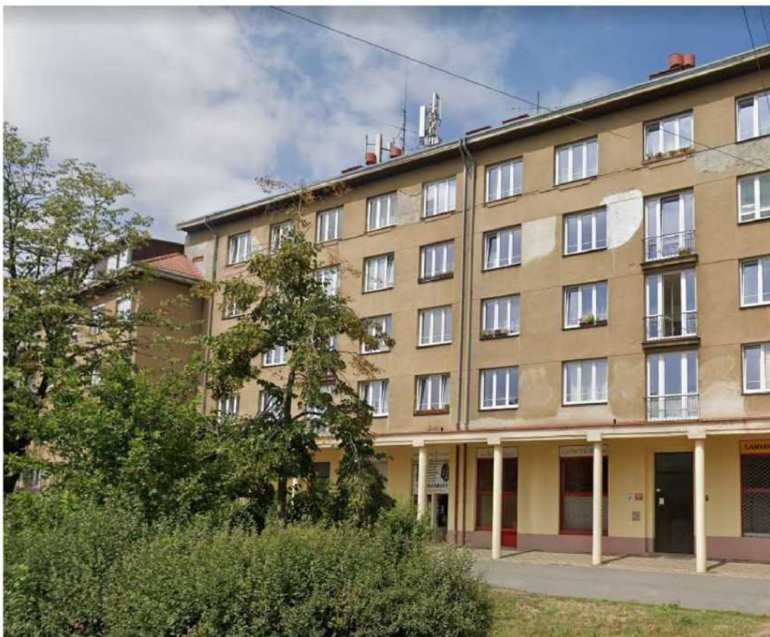
Pohled na budovy č. p. 1801 a 1802 od ulice Průběžné, Praha 10 – Strašnice
