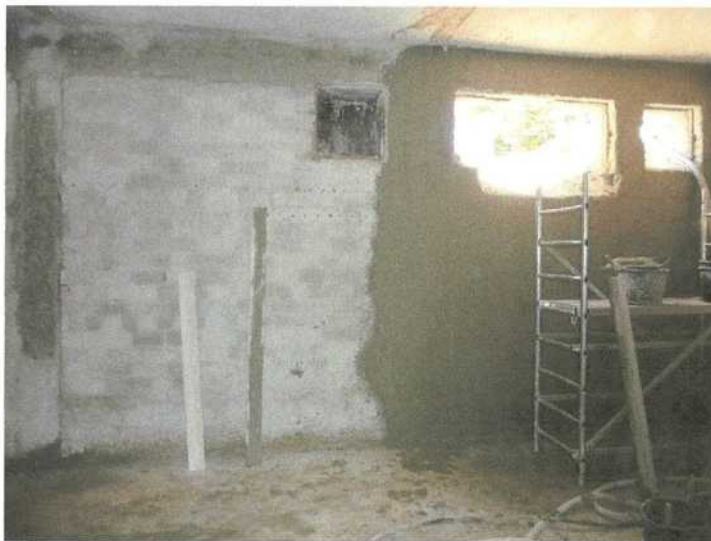
úprava obvodových stěn a injektáž
