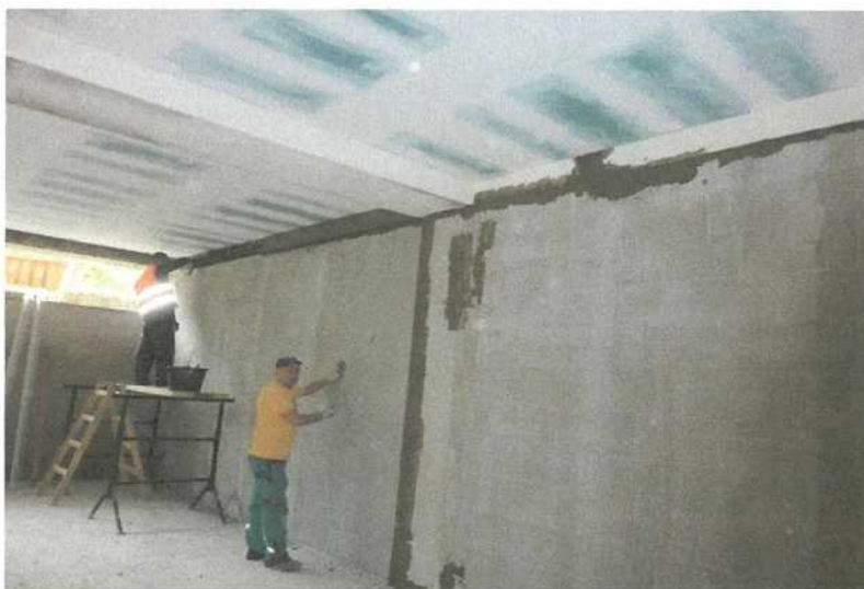
úprava stěn a stropů v sádrokartonu
