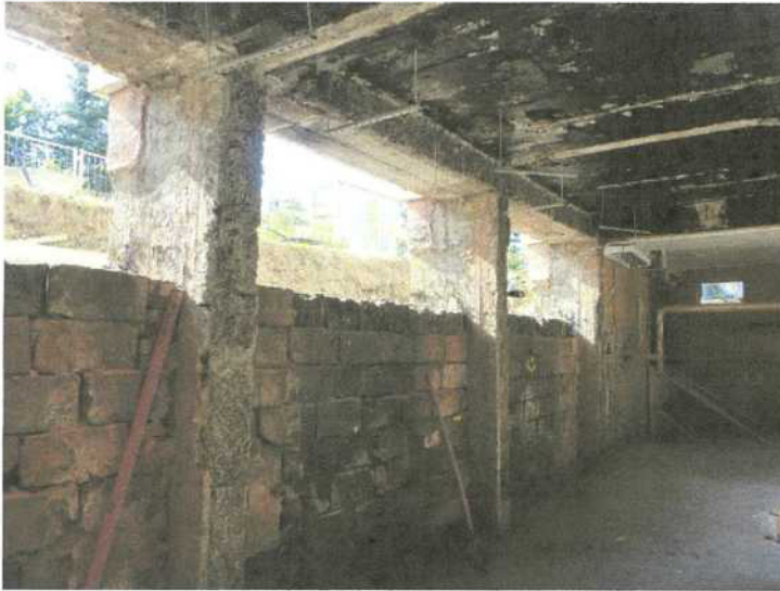
Stav obvodového zdiva a stropů
