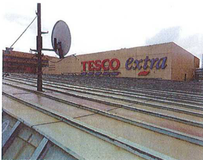
Měděná střecha sálu
