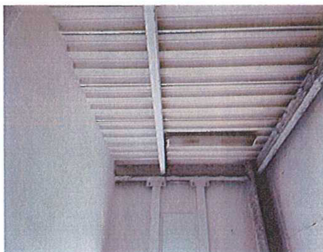
Stropní nosník a trapézový plech bez protipožární ochrany
