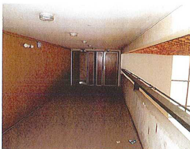
Dřevěné obklady stěn
