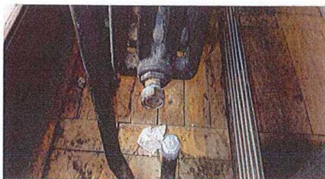
Odpojený radiátor topení
