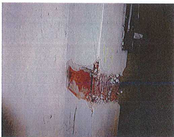
Sonda V3, obezděný ocelový sloup
