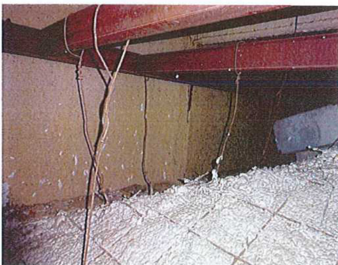
Zavěšený rabricový podhled sálu
