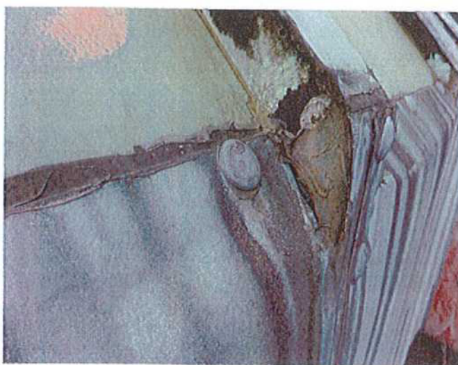
Kontakt měděného a pozinkovaného plechu
