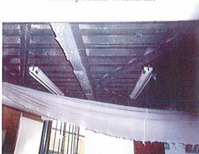
Části podhledu tvoří napnutá textilie
