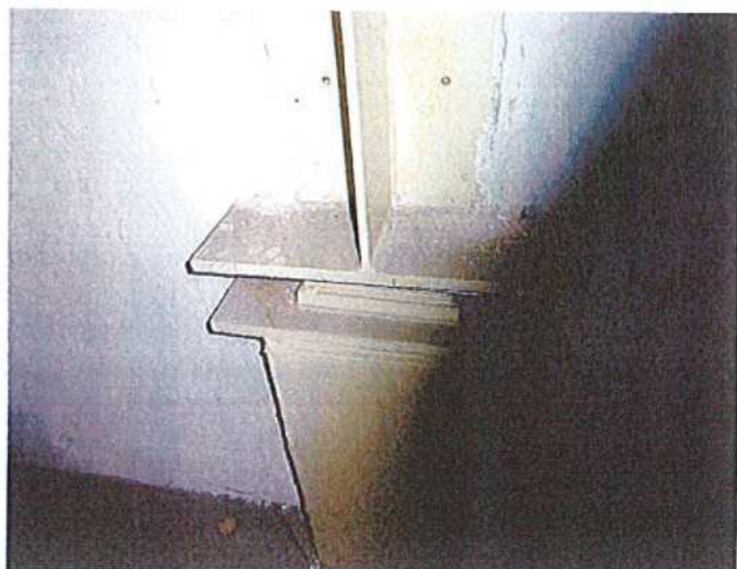
Uložení nosníku víceúčelového sálu na sloup
