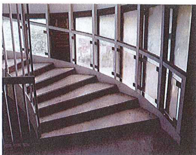
Ocelové schodiště, skleněný plášť
