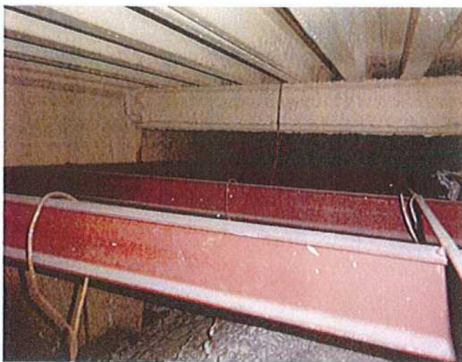
Strop nad sálem, hlavní nosník, nosníky střechy a zavěšeného podhledu
