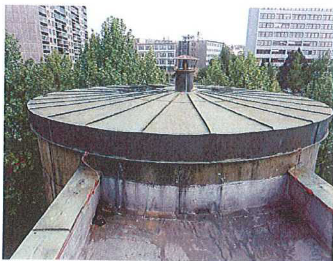
Měděná střecha schodiště
