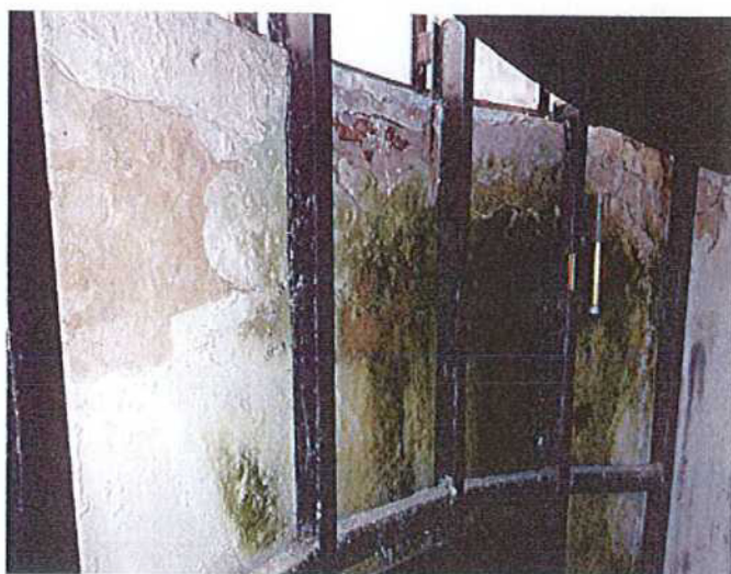
Schodiště, vyzdřená část obvodového pláště
