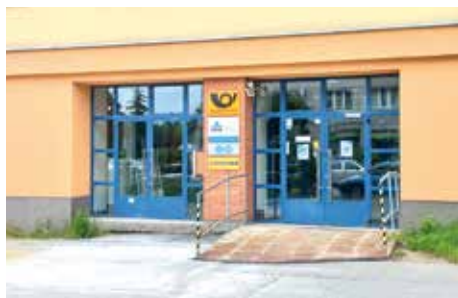
RUŠENÁ POŠTA V LITEVSKÉ ULICI
