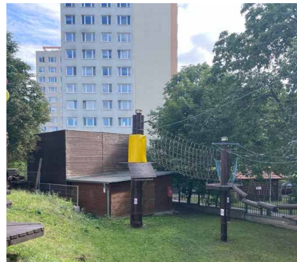
obr. 67. Nafukovací haly jsou mimo zimní sezónu uskladněny ve skladu, který je dostupný jenom z ulice, což je provozovatelem areálu hodnoceno jako nevhodné řešení, zdroj: 4ct, 2024
