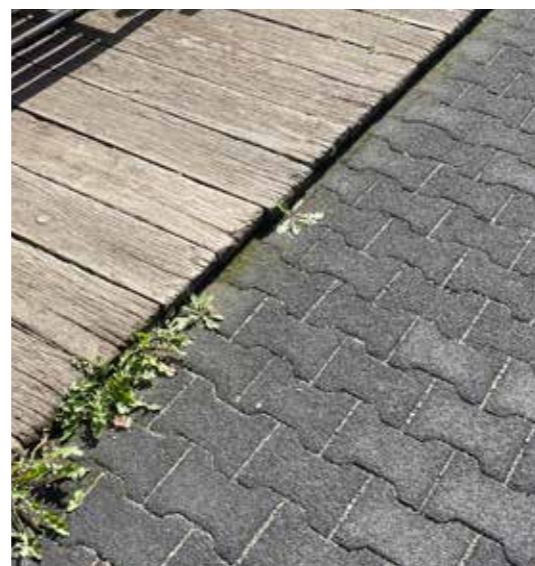
obr. 26. Betonová zámková dlažba, dřevěná prkna, zdroj: 4ct, 2024
