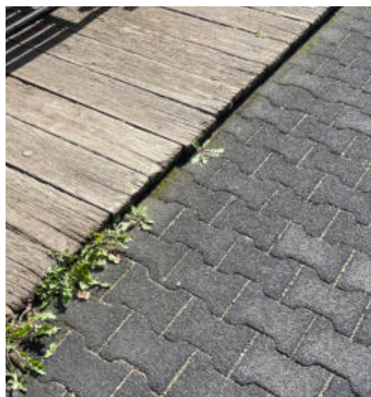
obr. 46. Betonová zámková dlažba, dřevěná prkna, zdroj: 4ct, 2024
