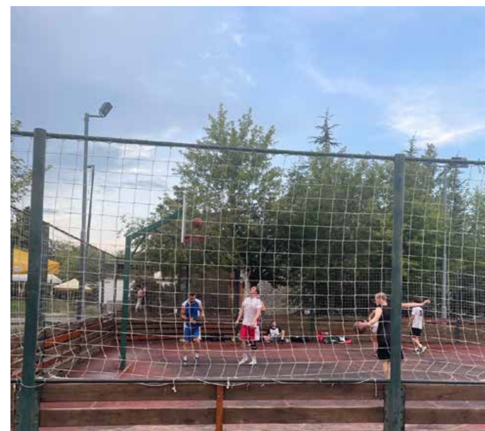
obr. 45. Multifunkční hřiště – aktuální podoba – povrch je ve špatném stavu, zdroj: 4ct, 2024
