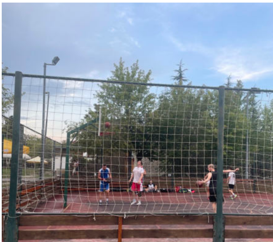
obr. 07. Multifunkční hřiště – aktuální podoba – povrch je ve špatném stavu, zdroj: 4ct, 2024
