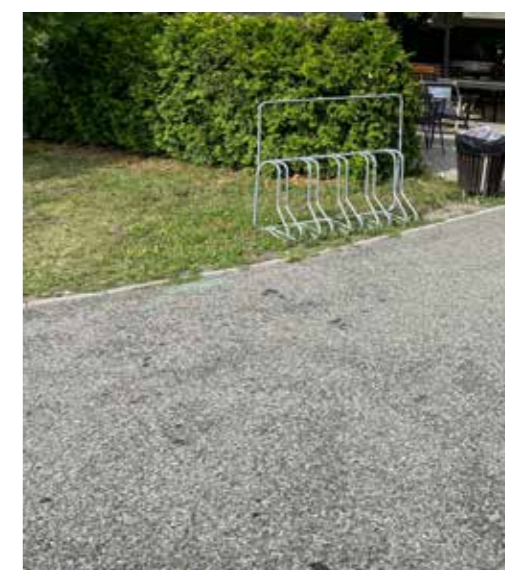
obr. 24. Stojan na kola, kterého design není vhodný pro kola s kotoučovými brzdami, zdroj: 4ct, 2024
