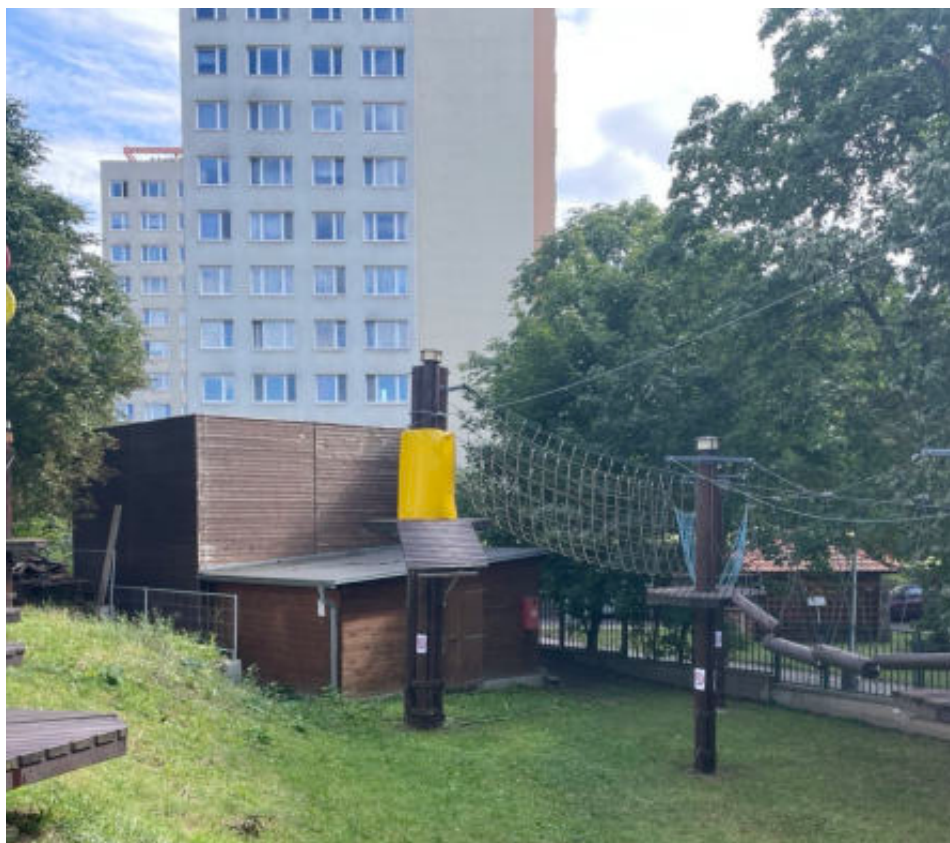
obr. 29. Nafukovací haly jsou mimo zimní sezónu uskladněny ve skladu, který je dostupný jenom z ulice, což je provozovatelem areálu hodnoceno jako nevhodné řešení, zdroj: 4ct, 2024
