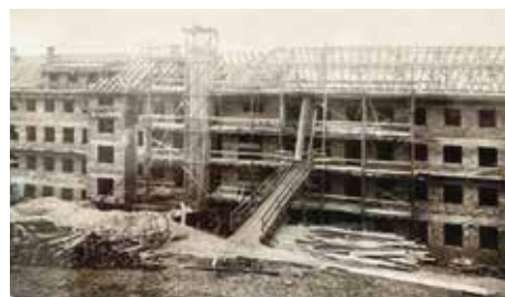
Výstavba budovy Střední zdravotnické školy
