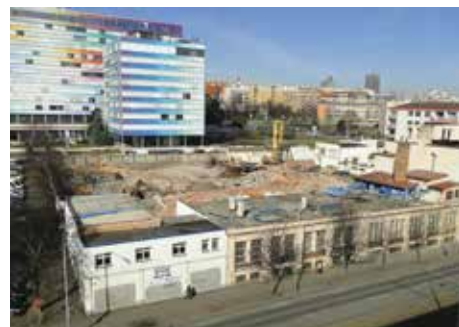
Demolice areálu Tesly v roce 2015
