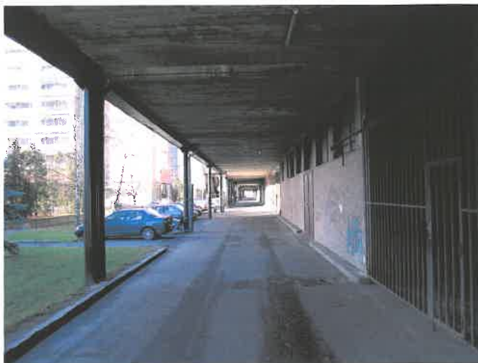
Obr. 3: Podhled terasy nad silniční komunikací
