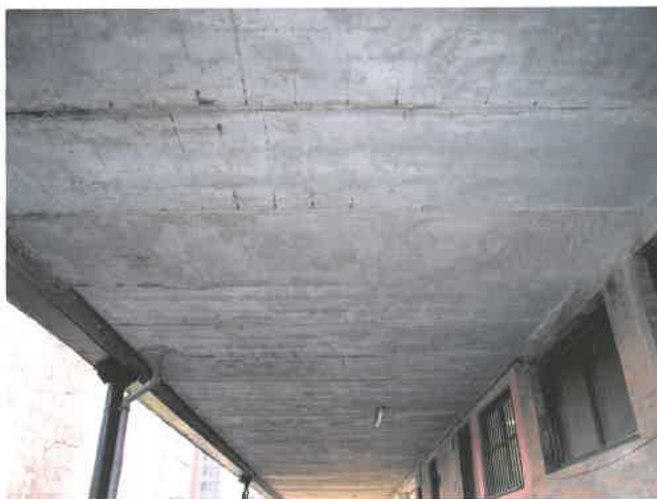
Obr. 4: Oprava podhledu u jednotlivého panelu nad komunikací
