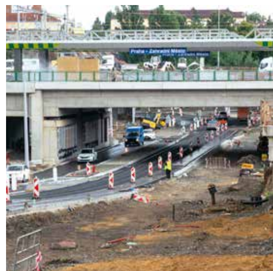
SITUACE NA STAVBĚ TERMINÁLU 23. 8. 2021
