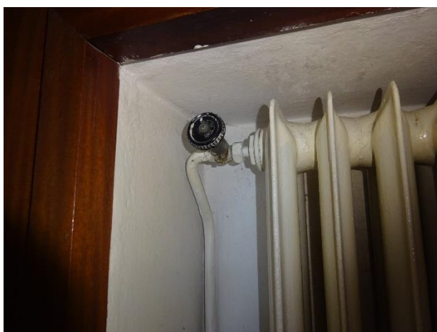
Ruční uzavírací kohout otopného tělesa
