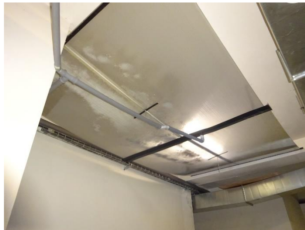
Provizorní odvod vody ze suterénu
