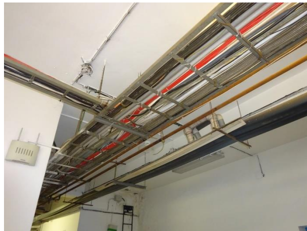
Trasa s vedením silnoproudu, slaboproudu a zdravotnické
