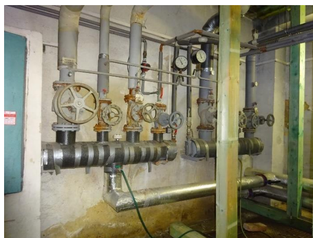
Podružný rozdělovač a sběrač
