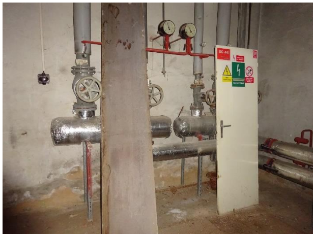
Podružný rozdělovač a sběrač
