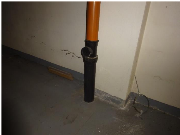
Plastové potrubí kanalizace napojené na původní litinové potrubí
