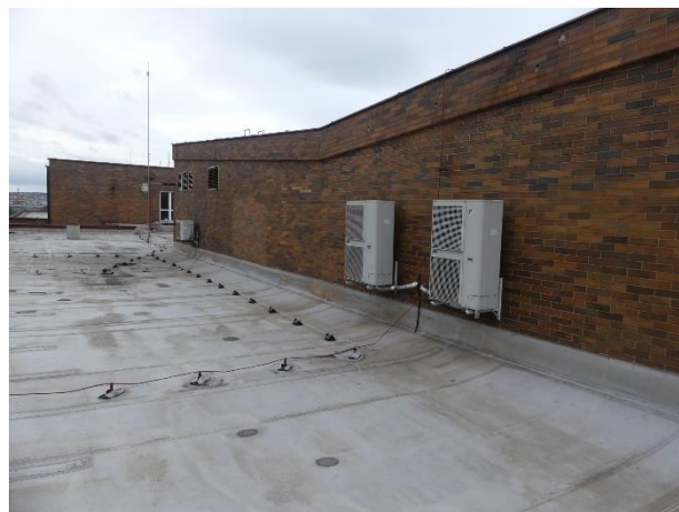
Pohled na střešku s lokálními opravami
