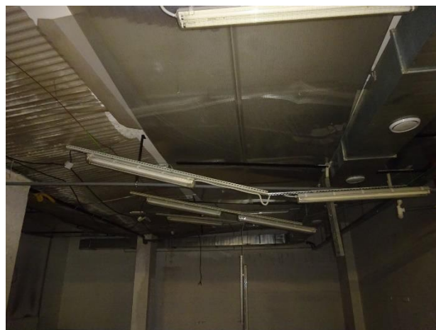
Provizorní odvod vody ze suterénu
