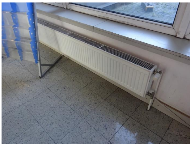
Novější deskové otopné těleso
