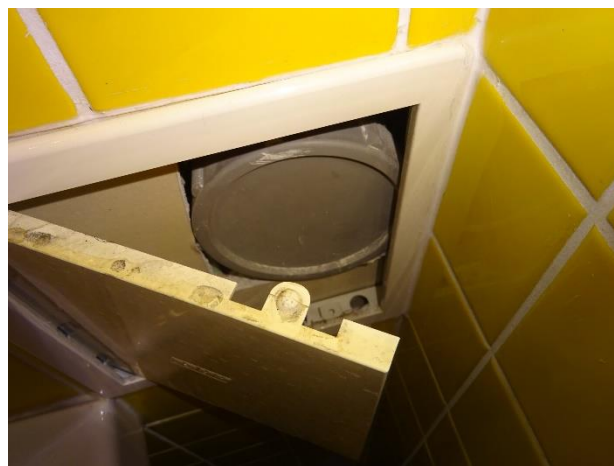
Čistící kus plastového kanalizačního potrubí
