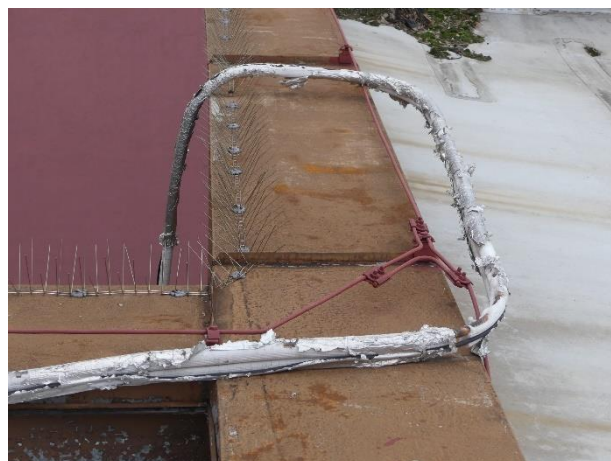
Pohled na degradující oplechování
