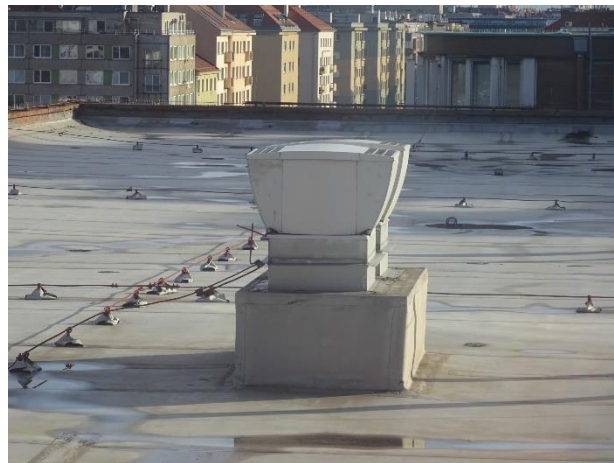
Střešní odtahové ventilátory
