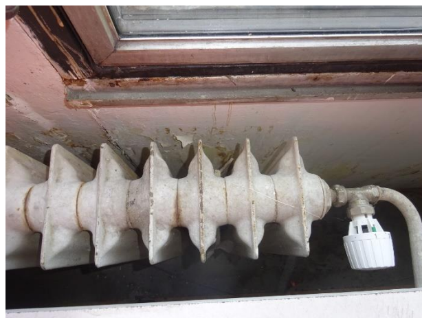
Detailní pohled na těleso s termostatickou hlaví
