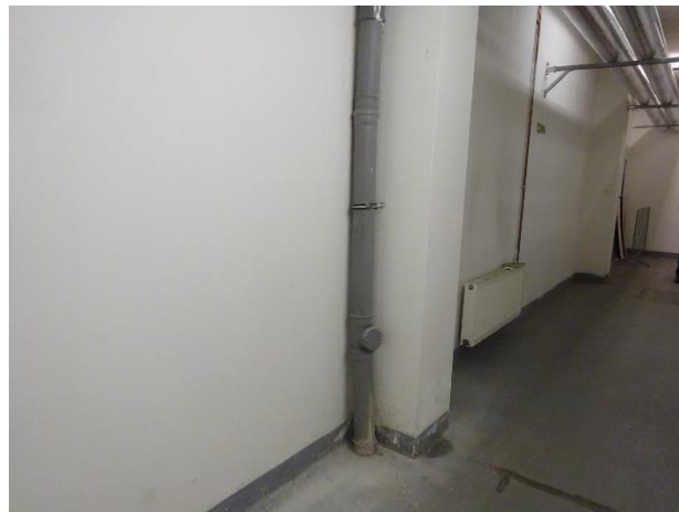
Plastové HT potrubí kanalizace
