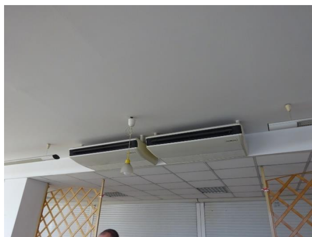
Vnitřní podstropní jednotky
