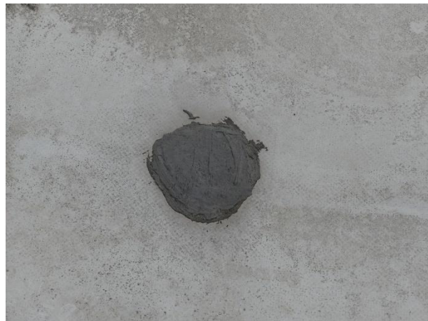
Lokální oprava pomocí tmelu
