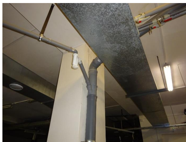
Provizorní odvod vody ze suterénu
