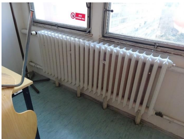
Typický koncový distribuční prvek tepla - litinové otopné těleso
