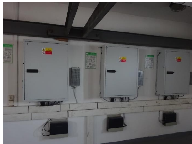
Novější elektroinstalace ve strojovně výtahu
