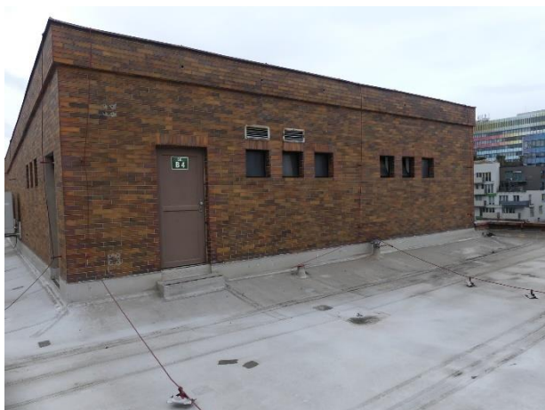
Pohled na střešku s lokálními opravami
