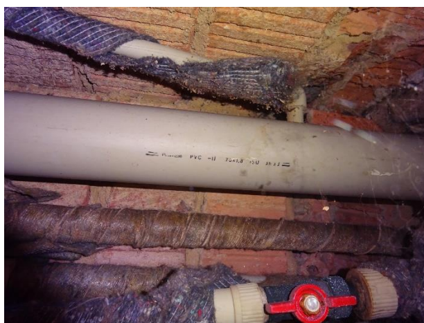
Instalační šachta – plastové PVC-U potrubí kanalizace
