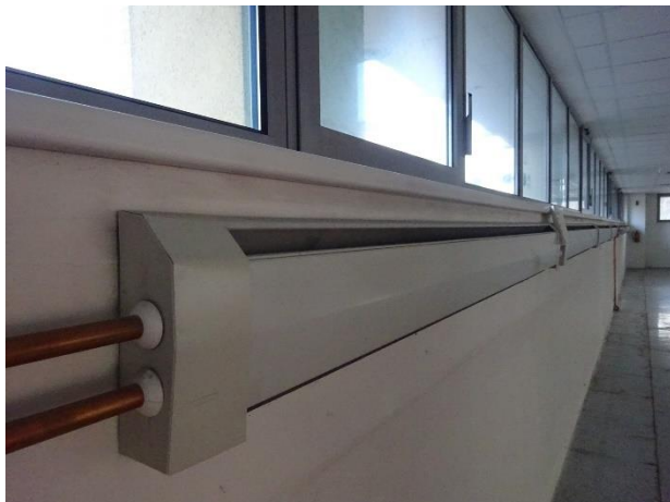
Nástěnné konvektory s topným registrem
