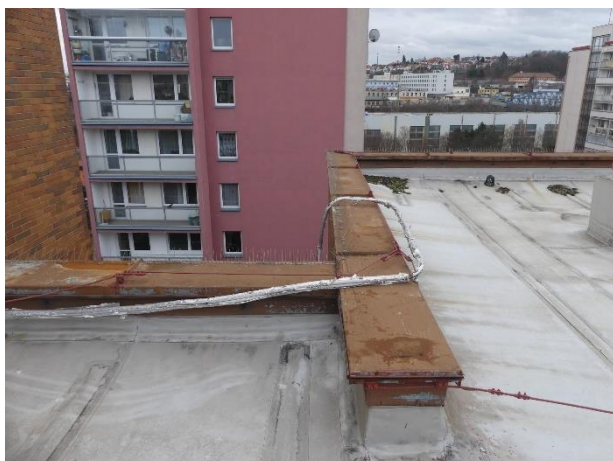
Pohled na degradující oplechování
