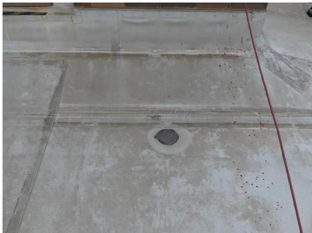
Lokální oprava pomocí tmelu
