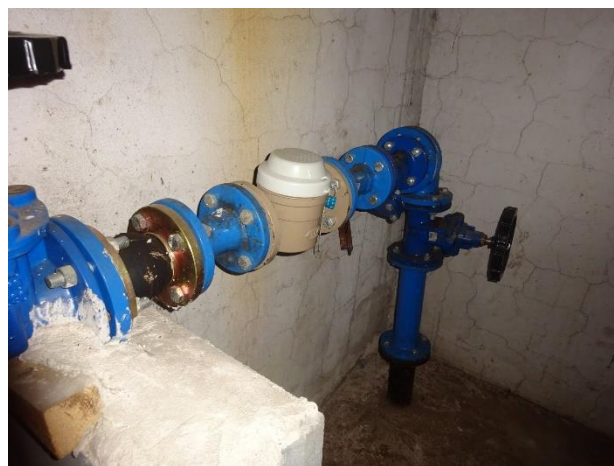
Detailní pohled na vyměněné litinové potrubí
