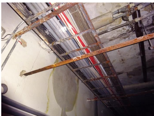
Trasa s vedením silnoproudu, slaboproudu a zdravotechiky
