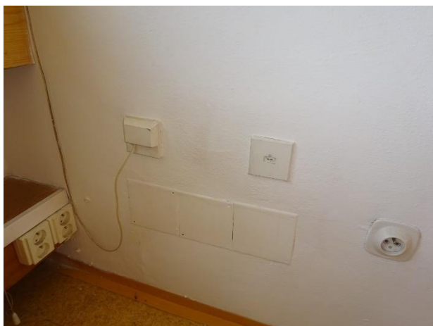
Silnoproudé a slaboproudé zásuvky
