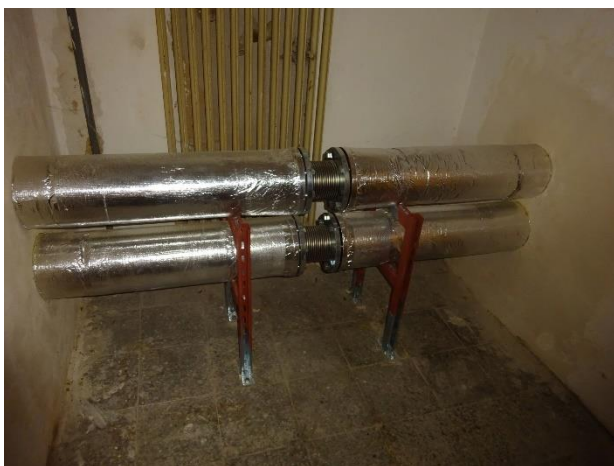
Zrekonstruované hlavní ležaté potrubí v suterénu
