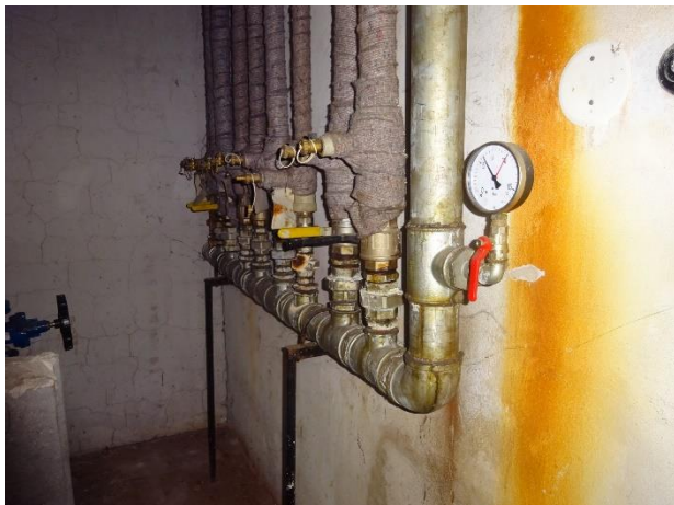
Rozdělovač pitné vody
