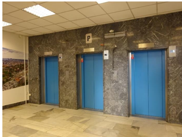
Pohled na dveře výtahů v přízemí
