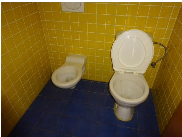
Zrekonstruované sociální zařízení (přízemí)
