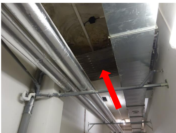
Provizorní odvod vody ze suterénu
