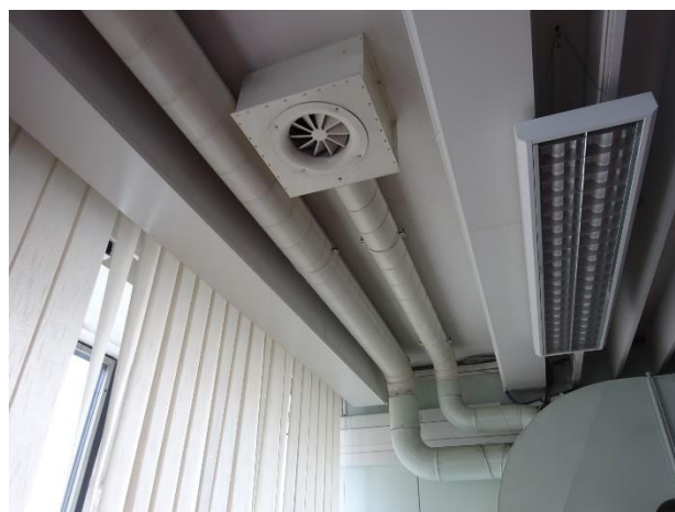
Přívodní anemostat
