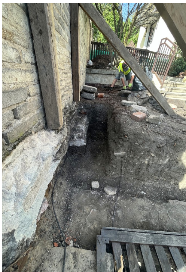
Obr.2 Provedený výkop podél plotové zdi na p.č.3118, odhalení způsobu a hloubky založení plotové zdi
