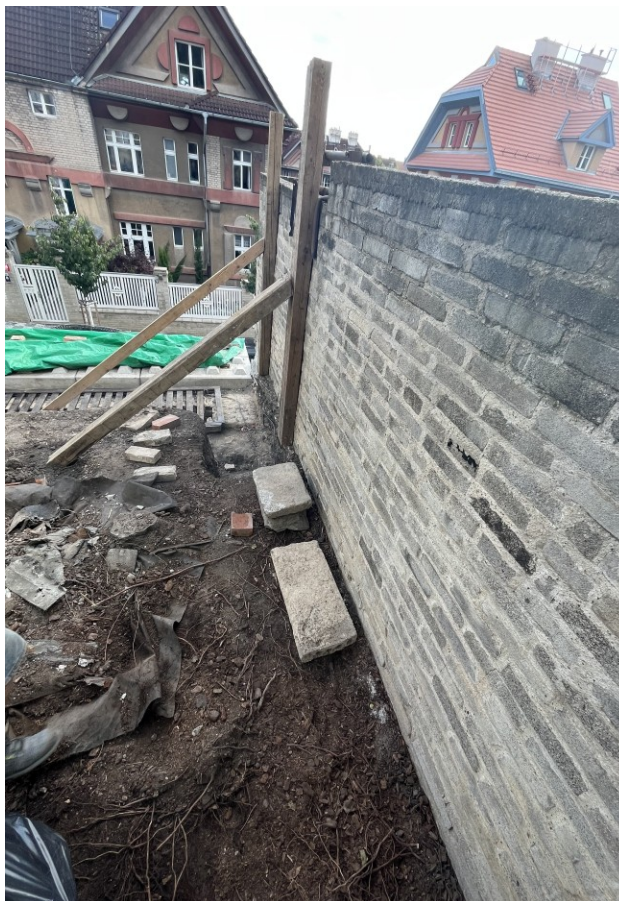
Obr.1 Pohled na plotové zdivo z p.č. 3118 k ulici Hradešínská
