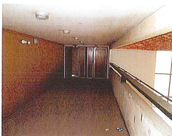
Dřevěné obklady stěn
