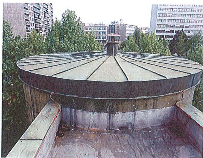
Měděná střecha schodiště
