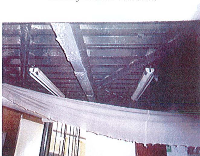
Části podhledu tvoří napnutá textilie
