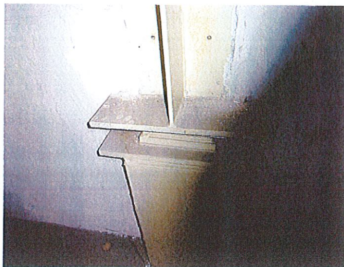
Uložení nosníku víceúčelového sálu na sloup
