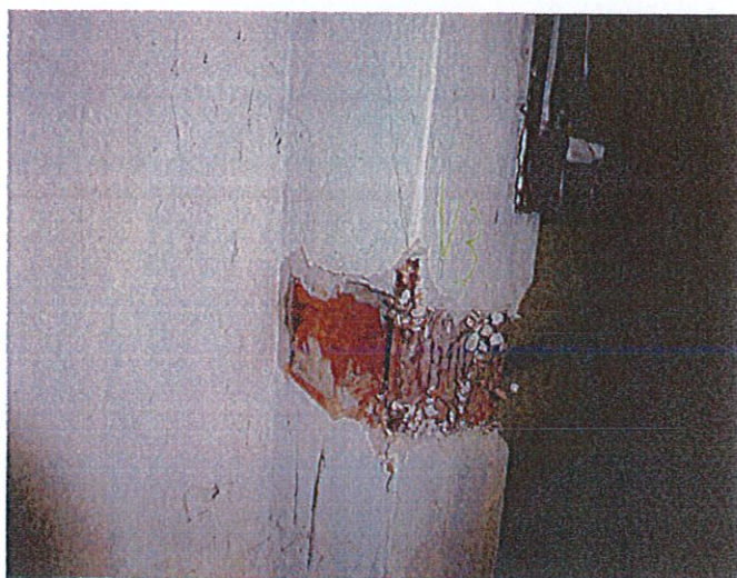
Sonda V3, obezděný ocelový sloup
