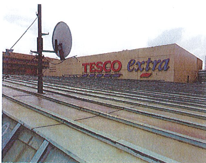
Měděná střecha sálu
