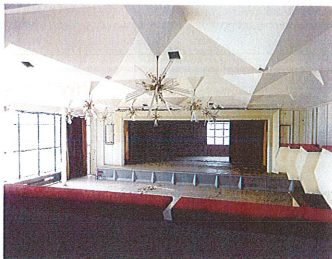
Pohled do víceúčelového sálu, líc podhledu
