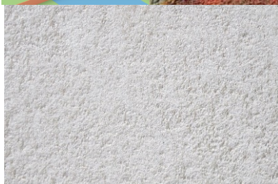
bílá fasáda přístavby
