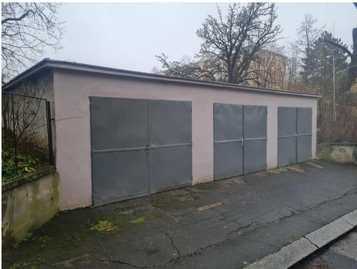
Obrázek 2 Garážový objekt určený k demolici
