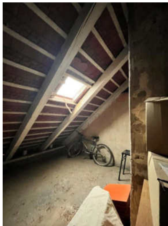
Levá část podkroví
