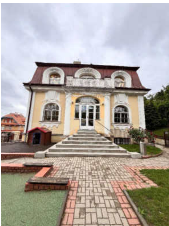
Východní průčelí objektu
