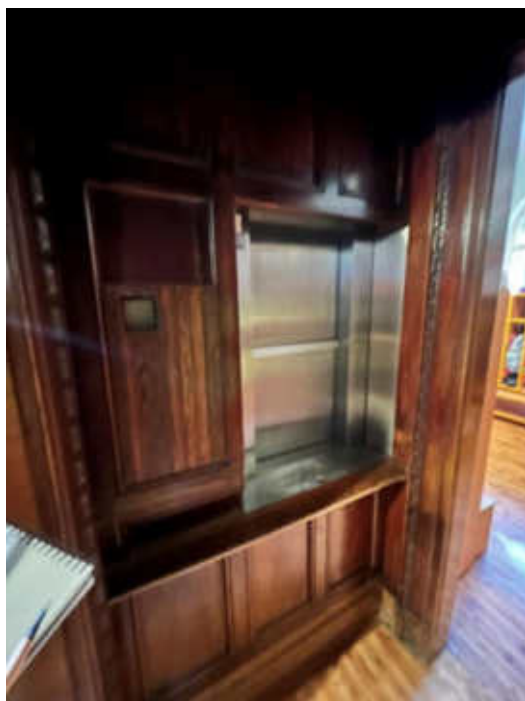
Výtah na jídlo
