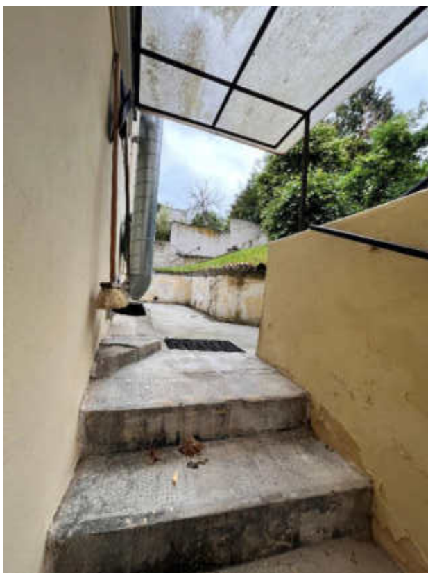
Vstup na zahradu + služební vchod
