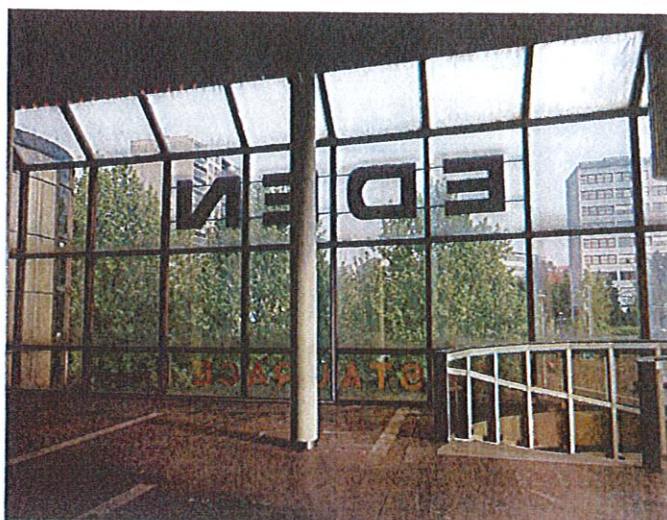
Skleněná část fasády
