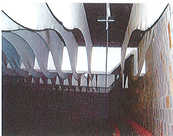
Stropní nosníky nad kinosálem
