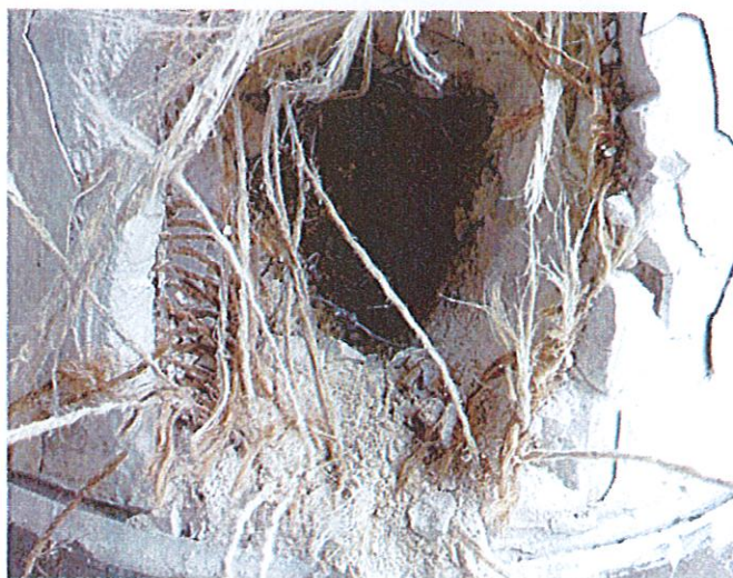
Sonda V7, ocelový sloup
