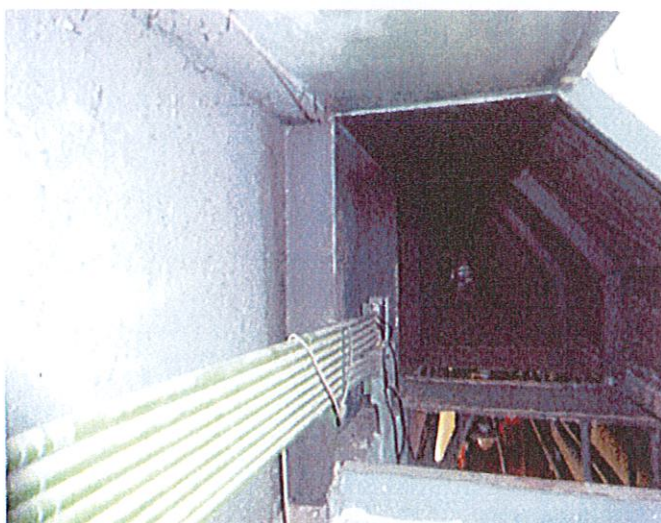
Nosník nad jevištěm
