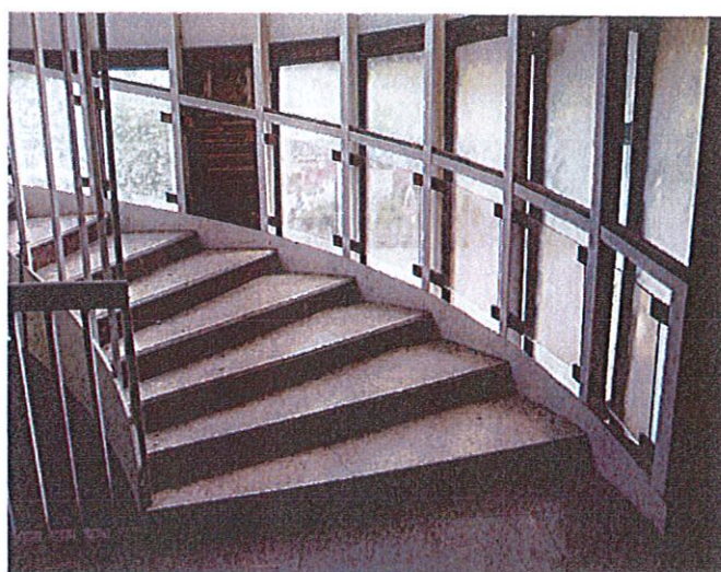
Ocelové schodiště, skleněný plášť
