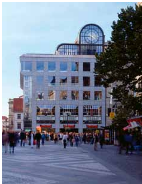
ADMINISTRATIVNÍ BUDOVA ČKD NA MŮSTKU, DNES OBCHOD NEW YORKER, ZDROJ: WWW.EHL-KOUMAR.CZ
