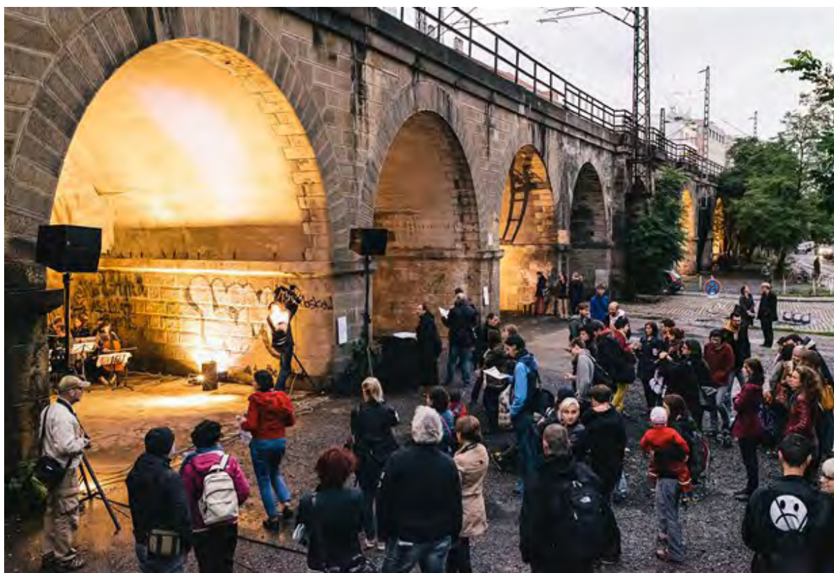
Negrelliho viadukt v Praze
