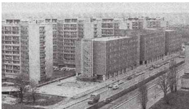
SÍDLIŠTĚ VLASTA NA POČÁTKU VÝSTAVBY A PO DOKONČENÍ
