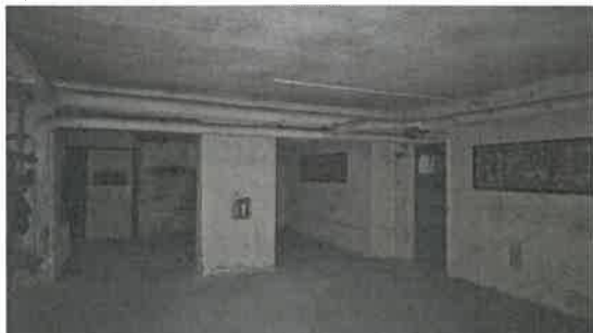
Vnitřní prostory Nemovitosti (1.PP)
