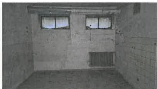
Vnitřní prostory Nemovitosti (1.PP)
