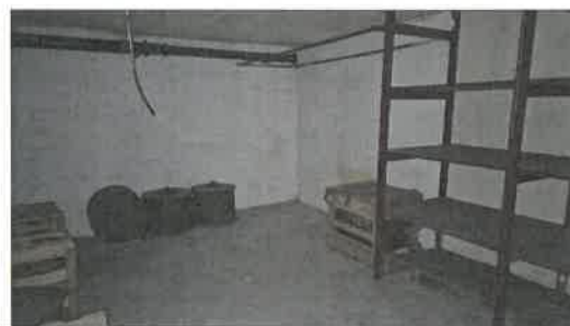
Vnitřní prostory Nemovitosti (1.PP)
