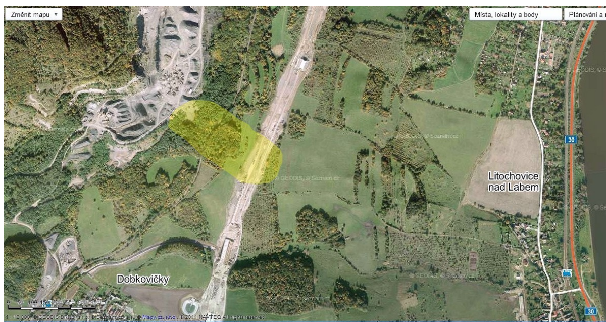
Obr. 1 Lokalizace sesuvu ve vztahu k dálnici D8, obci Litochovice, a řece Labe.
